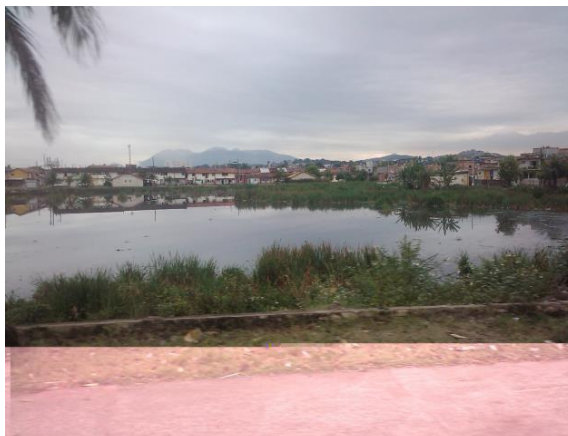
Figura 36: Condomínios construídos pelo programa Habitar Brasil em Duque de Caxias. Fonte: acervo pessoal do autor.
