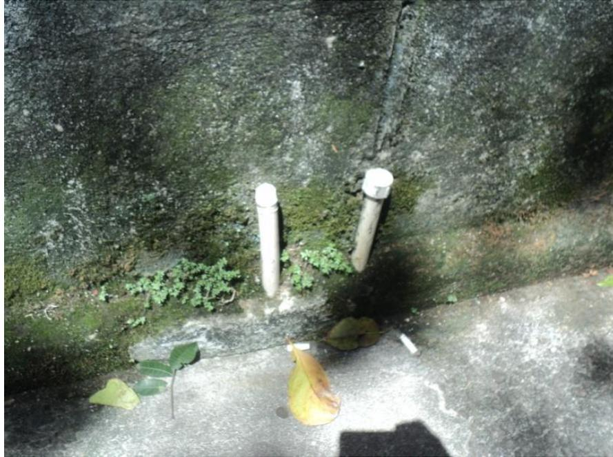
**Figura 6.8** - Um dos vários pares de canaletas instalados em grande parte dos domicílios do Mata Machado durante o Programa Favela Bairro para a conexão da comunidade à rede geral de abastecimento de água regular, jamais concretizada. Fonte: arquivo pessoal.
