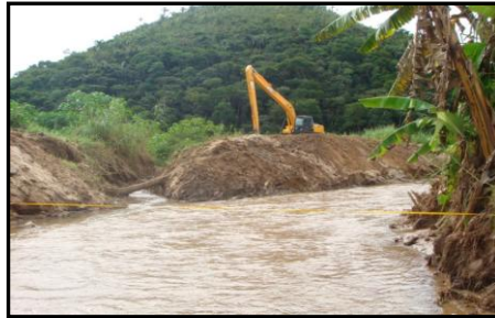
Figura 4.6 – Dredge removendo a vegetação da margem direita do Córrego Sujo. Fotografia tirada durante a medição da vazão do mês de abril de 2012.
