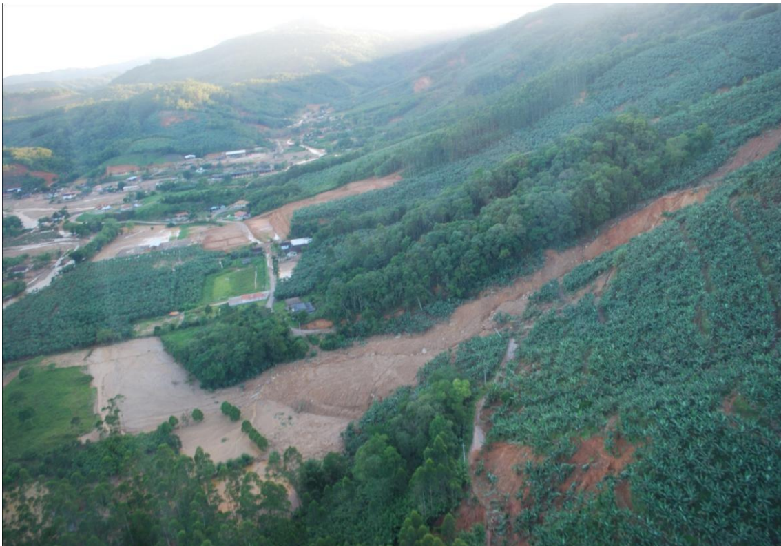
Figura 1.2: Deslizamentos em plantações de banana no Complexo do Morro do Baú. Foto: Joel Pellerin (2008).
