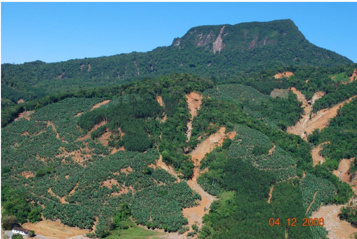
Figura 4.10: Cicatrizes de deslizamentos ocorridas em Novembro de 2008 no Morro do Baú. Foto: Nelson Fernandes (2008).
