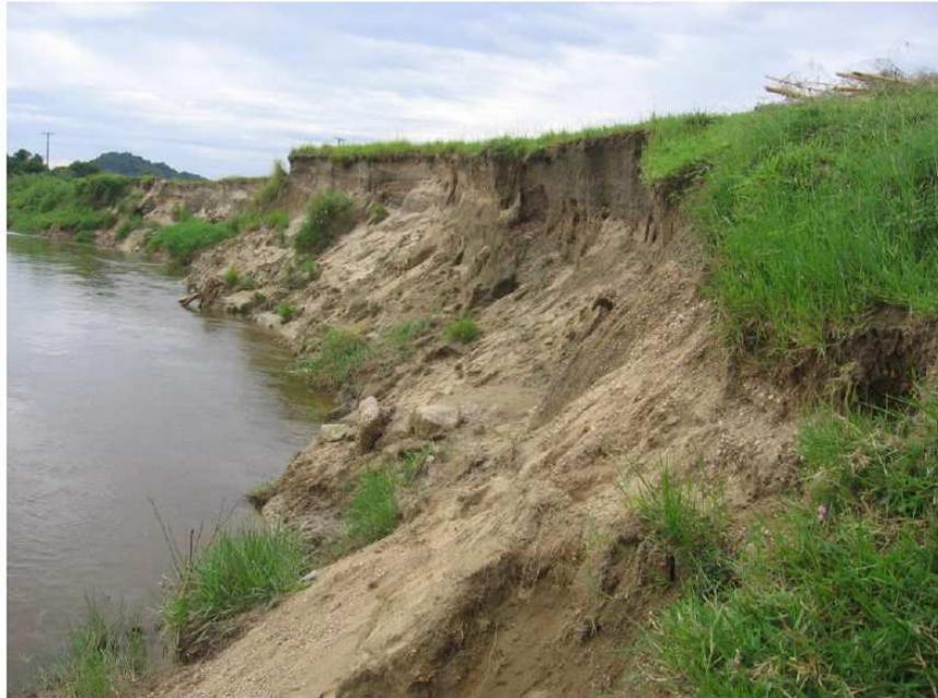
**Figura 25** Erosão de margens como resultado da canalização e tendência do canal de recuperar a sinuosidade.
