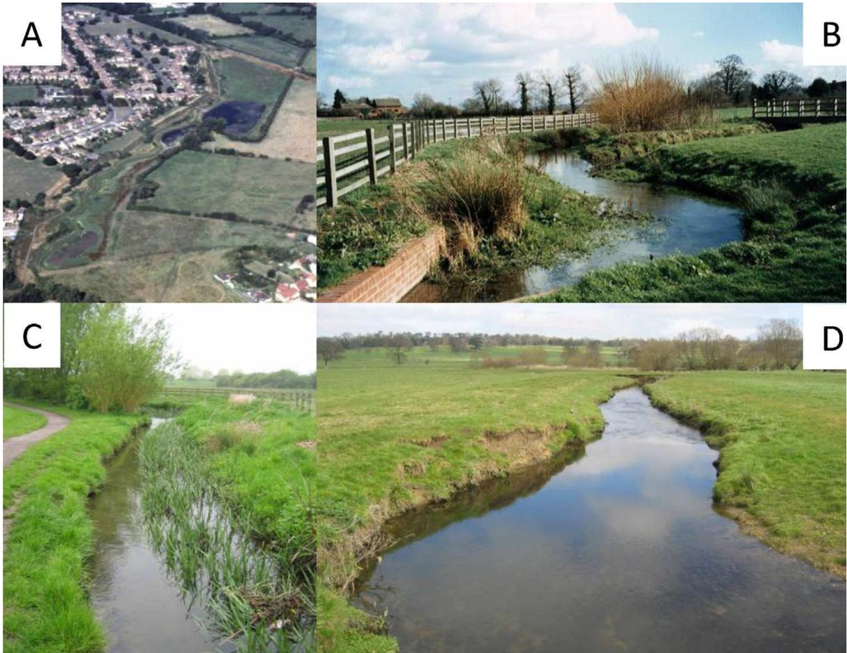
**Figura 13** Diferentes cenários do córrego Bear em seu projeto de restauração: (A) Vista aérea com armazenamento da inundação; (B) quatro anos após a intervenção e a vegetação está moldando o canal; (C) em 2006, o estreitamento do canal devido a deposição de sedimentos; (D) o rio Cole, com pouco desenvolvimento.
