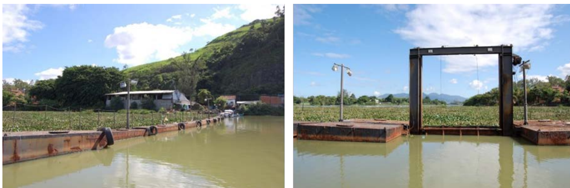
Figura 47. Presença de barreira artificial para controle do avanço de plantas aquáticas que atravessa transversalmente à lagoa. Fonte: Autora.
