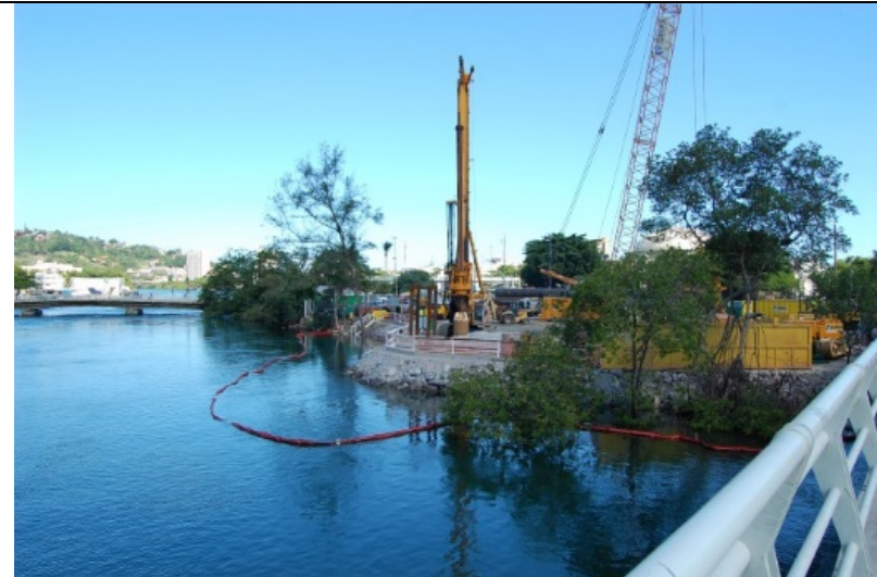
Construções pela extensão da linha do Metrô para a Barra da Tijuca
