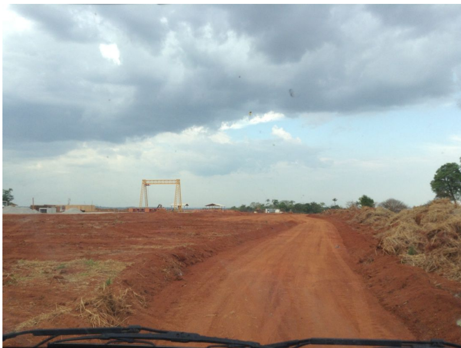
Silo da Amaggi em construção, em Matupá, setembro de 2013
