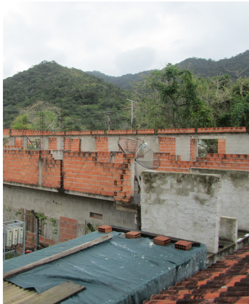
Figura 26 – Construções na Vila de Trindade. Foto: Luana Balbino (Julho/2014).
