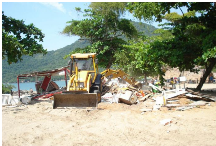
Figura 27 – Demolição de quiosque na Praia do Meio (Foto: ICMBio, 2015)
