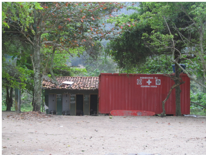
Figura 24 – Falta de estrutura para receber turistas, ausência de banheiros e cabine de bombeiros improvisada. Foto: Luana Balbino (Outubro/2014).
