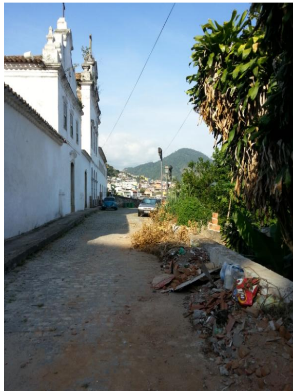
Figura 38: Geomorfossítio Mirante do Convento São Bernardino de Sena em situação degradante, com acúmulo de lixo e entulho em sua área, além da necessidade de poda das árvores que o circunda.
