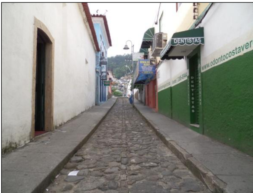
Figura 18: Travessa Santa Luzia. Presença de calçamento pé de moleque. Fotografia: E. A. L. Pocidonio (Abril/2014).
