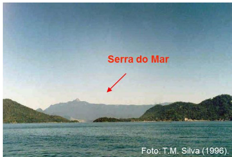
Figura 8: Visão panorâmica da Serra do Mar a partir da Baía de Angra dos Reis. Observa-se o forte controle estrutural E-W do compartimento serrano. Foto: T.M.Silva (Ago./1996).
