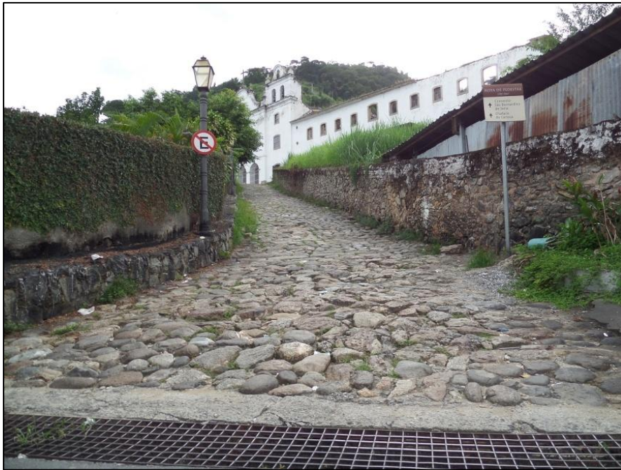
Figura 17: Convento São Bernardino de Sena. Presença de calçamento pé de moleque. Fotografia: E. A. L. Pocidonio (Abril/2014).
