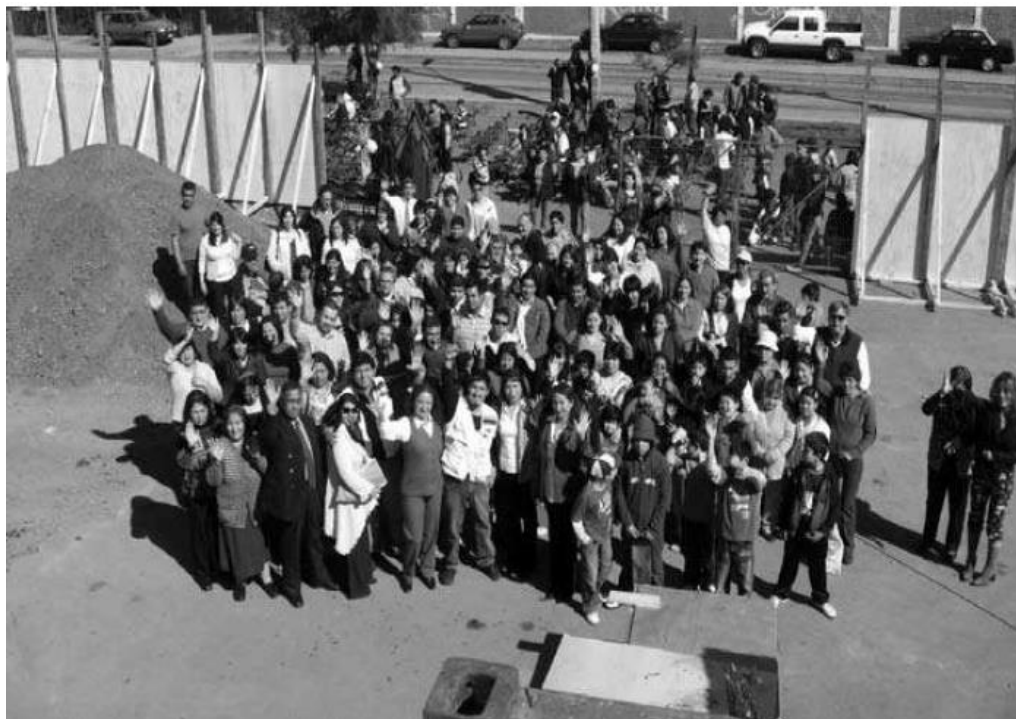
Ilustração 8. Cerimônia de colocação de primeira pedra do projeto MPL2, setembro de 2009. Fonte: MPL (2011).
