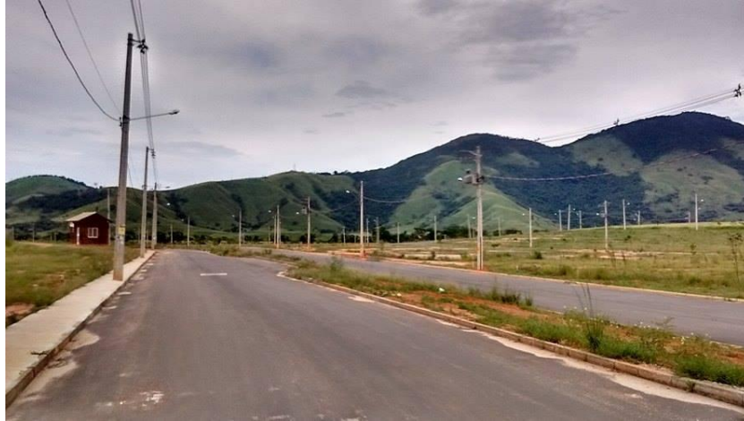
Figura 18: logradouro recentemente aberto entre o Reserva da paz e o Alvorá Parque Novo.
