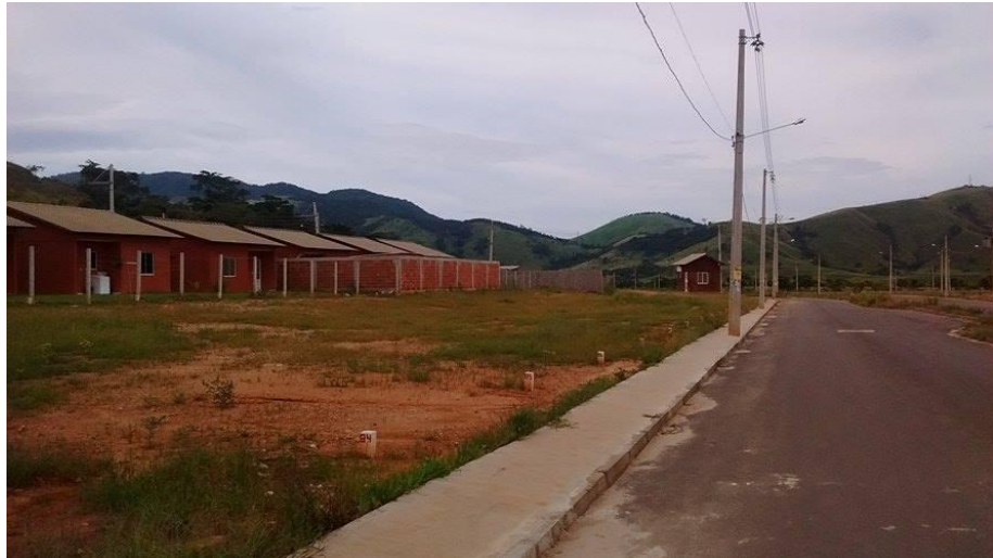
Figura 17: muros sendo construídos ao redor das casas do Reserva da Paz.
