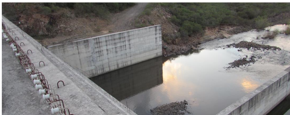
Foto 7: Vertedouro da barragem do rio Tacuarembó ainda não concluída, no município de Dom Pedrito (RS). Fonte: L. P. Batista da Silva, agosto de 2016.
