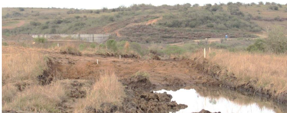
Foto 6: Área que deverá ser alagada para o reservatório do rio Tacuarembó, no município de Dom Pedrito, na Faixa de Fronteira do RS. Ao fundo, um segmento da barragem, ainda em construção. Fonte: L. P. Batista da Silva, agosto de 2016.
