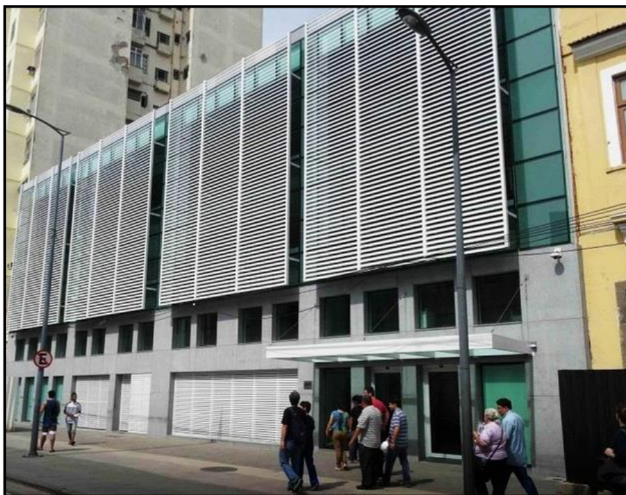
Foto 19: Rua Sacadura Cabral. Instalação da sede da CDURP
