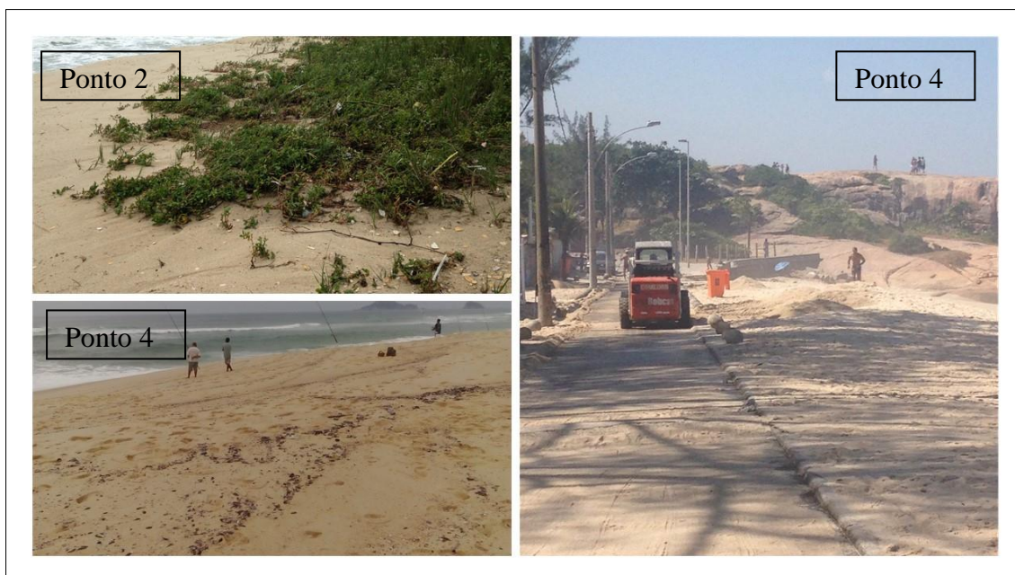
Figura 40 - Evidência de Overwash nos pontos 2 e 4.
