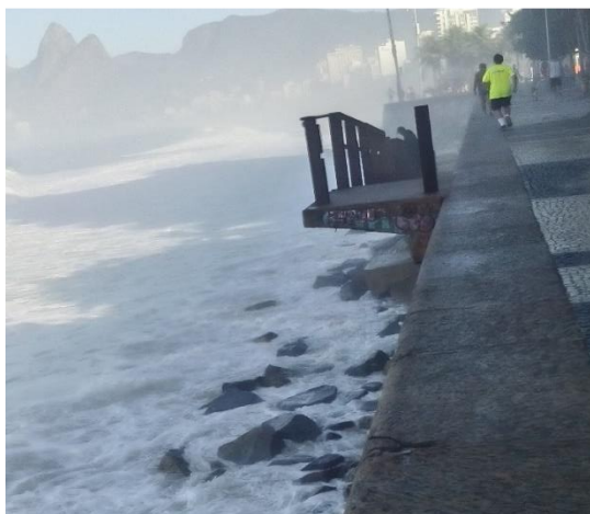
Figura 71 - Perda de sedimentos durante ressaca do dia 21 e 22 de abril de 2016.
