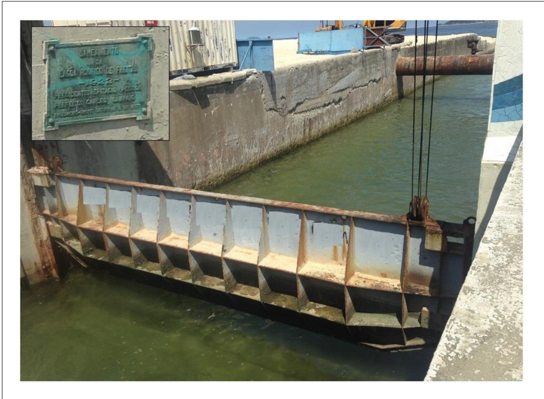
Figura 77- Estrutura que controlada a vazão do canal de maré Jardim de Alah.
