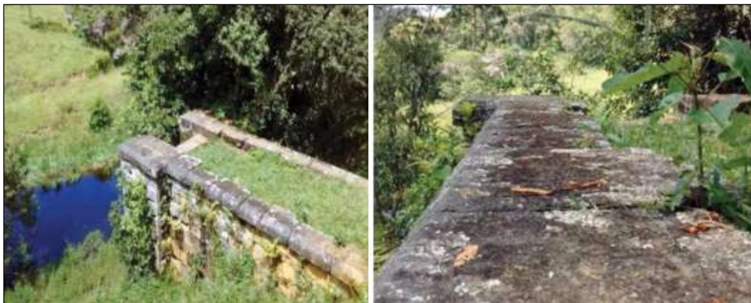
Figura 31. Estrutura em pedras onde seriam colocados os trilhos e o que sobrou de uma ponte onde passariam os vagões de trem. Fonte: Jornal Maranduba News, abril/2016.
