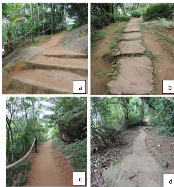
Figura 87. Trecho da trilha entre a Praia do Bonete e Lagoinha, com presença de corrimão e degraus (a e c) e piso de cimento (b e d). Foto: Maria Jorge (2014).
