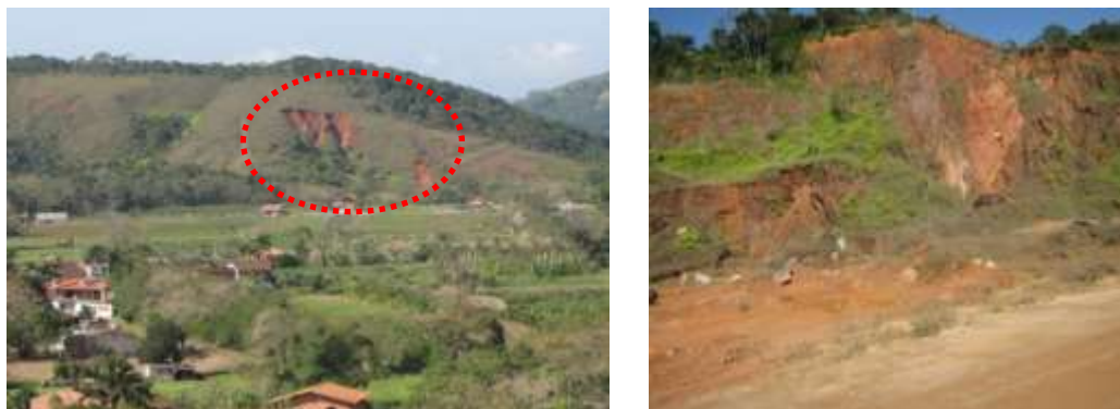
Figura 36. Paisagem modificada pela retirada de material de empréstimo e saibro. Hoje, desativadas, comprometem a estética do local e se tornam muito susceptíveis a processos erosivos. Foto: Maria Jorge (2010).
