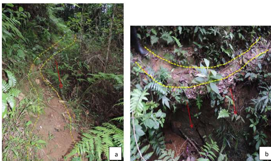
Figura 92. Trecho da trilha Água Branca, muito estreito e com solapamento em sua borda. Foto: Maria Jorge (2014).
