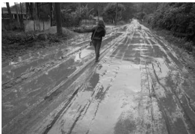
Figura 34. Condição da Estrada do Araribá, a principal do bairro Araribá, sul de Ubatuba, em período de chuvas intensas. A foto foi tirada em 2010, e até 2016, nenhuma melhora foi realizada. Foto: Maria Jorge (2010).
