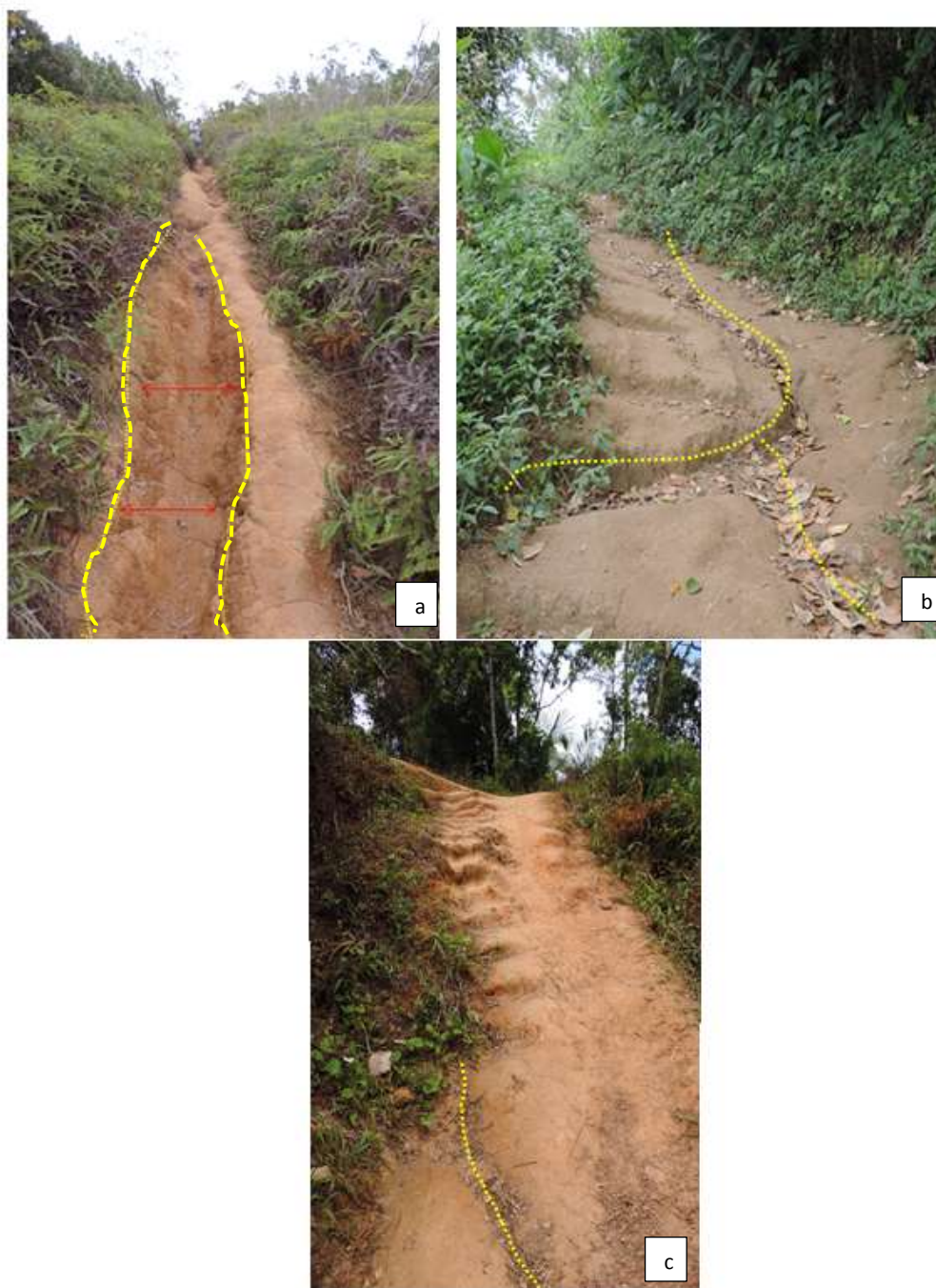
Figura 89. Localização dos trechos da trilha com processo erosivo. a. Ravina profunda localizada no centro da trilha, nota-se o alargamento da trilha, e diminuição da área de passagem de pedestre. b. Ravina cortando a trilha com fluxo superficial direcionado à borda da trilha. c. Presença de ravina no leito e na borda da trilha. Foto: Maria Jorge (2014).
