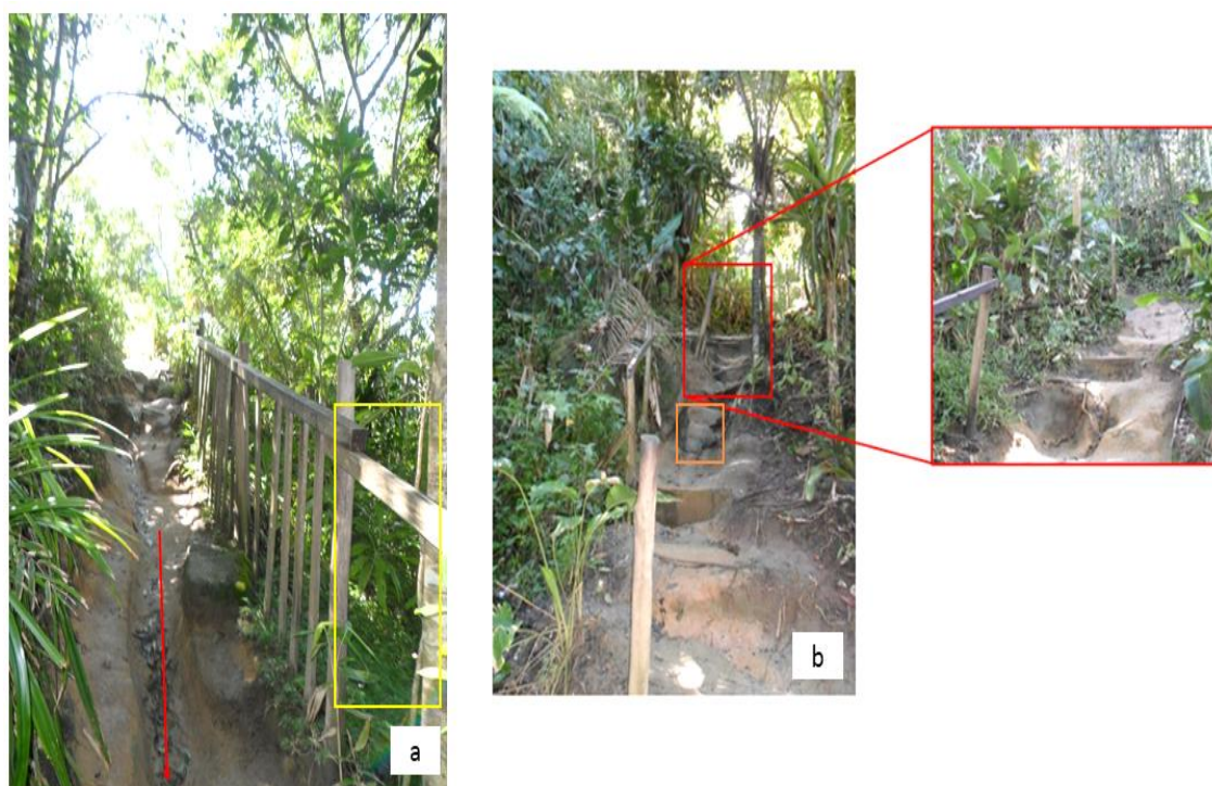
Figura 33. Impactos e degradações observadas na trilha PMC. (a) Ravina com acumulação de serapilheira leito da trilha (seta em vermelho) ao lado de estrutura de manejo danificada (destaque em amarelo). (b) Ponto onde os usuários têm dificuldade para se locomover: escada bastante danificada com degraus já erodidos (no detalhe), blocos e raízes expostos (destaque em laranja). Fotos: L. A. Rangel (2015).
