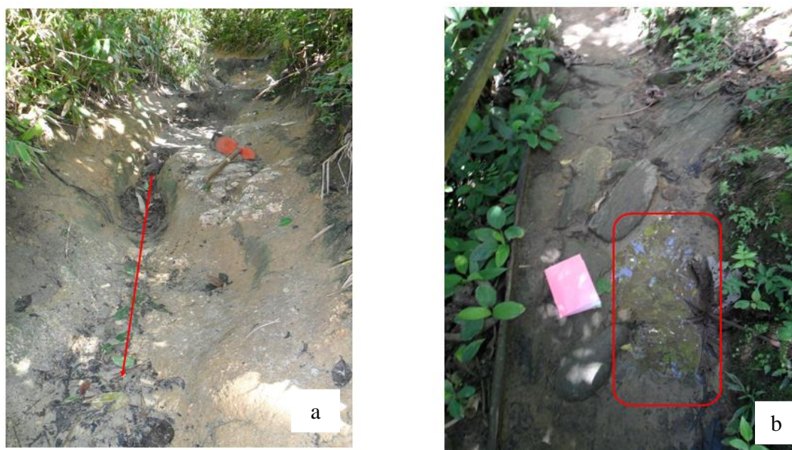
Figura 34. Impactos observados na trilha PNC. (a) Erosão acelerada com presença de ravina (em vermelho) e afundamento do leito. (b) Alagamento no leito (em vermelho) e presença de blocos rochosos. Fotos: L. A. Rangel (2015).
