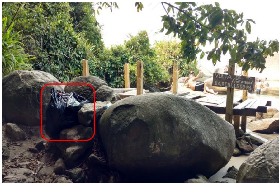
Figura 56. Setembro de 2017 - Retirada da cobertura da construção e acúmulo de lixo (destaque em vermelho). Foto: L. A. Rangel (2017).
