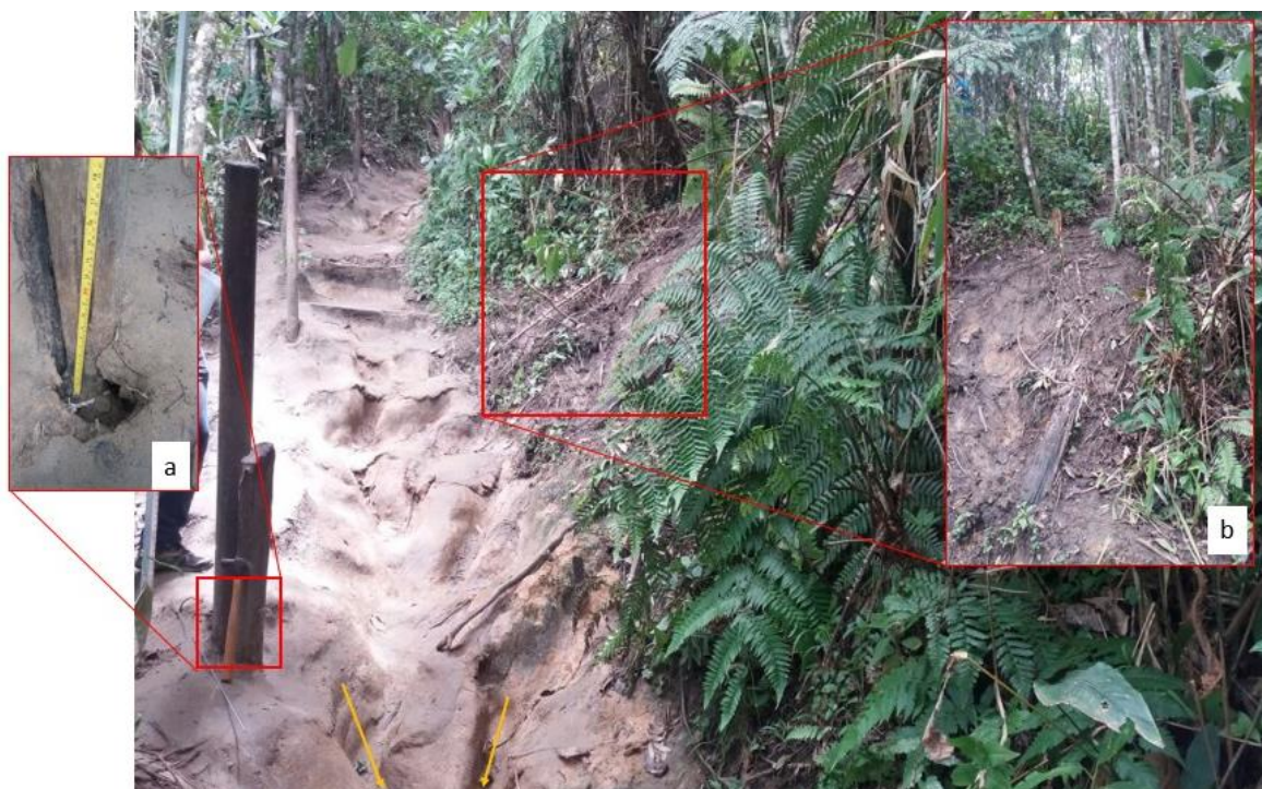
Figura 24. Alterações significativas no ambiente e na microtopografia do solo em PE 2 da trilha PMC em fevereiro de 2017, com deslizamento no talude superior e soterramento da estaca no talude superior (detalhe 'b'), erosão da estaca de nivelamento no talude inferior (detalhe 'a') e deposição de material no leito da trilha onde antes existiam ravinas (setas amarelas). Foto: L. A. Rangel (2017).
