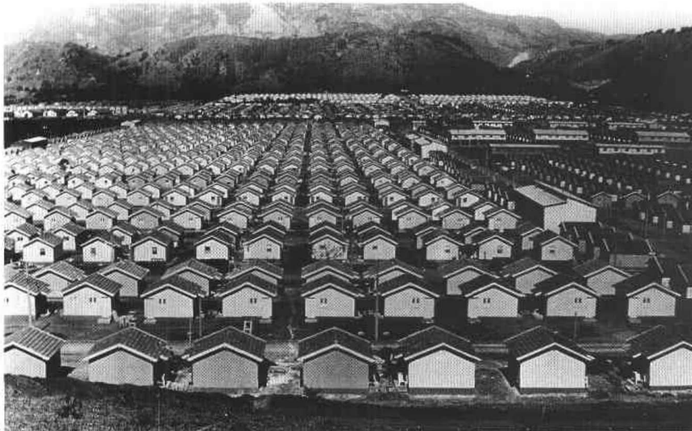
Figura 6 - Conjunto habitacional da Vila Kennedy, COHAB-RJ, 1965. Fonte: FREIRE; OLIVEIRA (2002).
