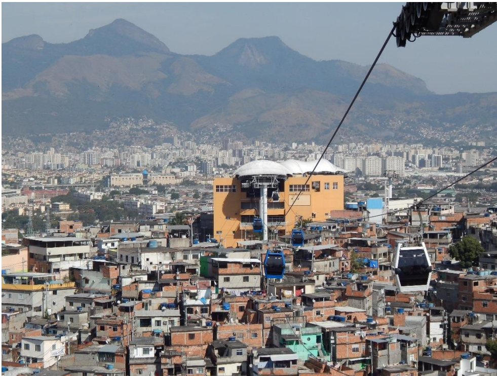
Figura 32 - Estação Itararé. Foto do Autor.
