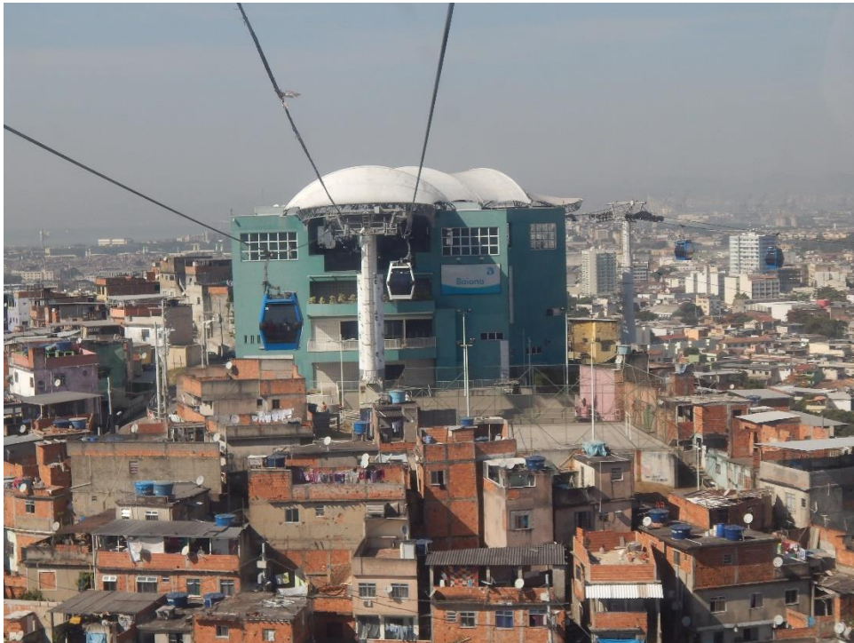
Figura 26 - Teleférico - Estação Baiana. Foto do autor.
