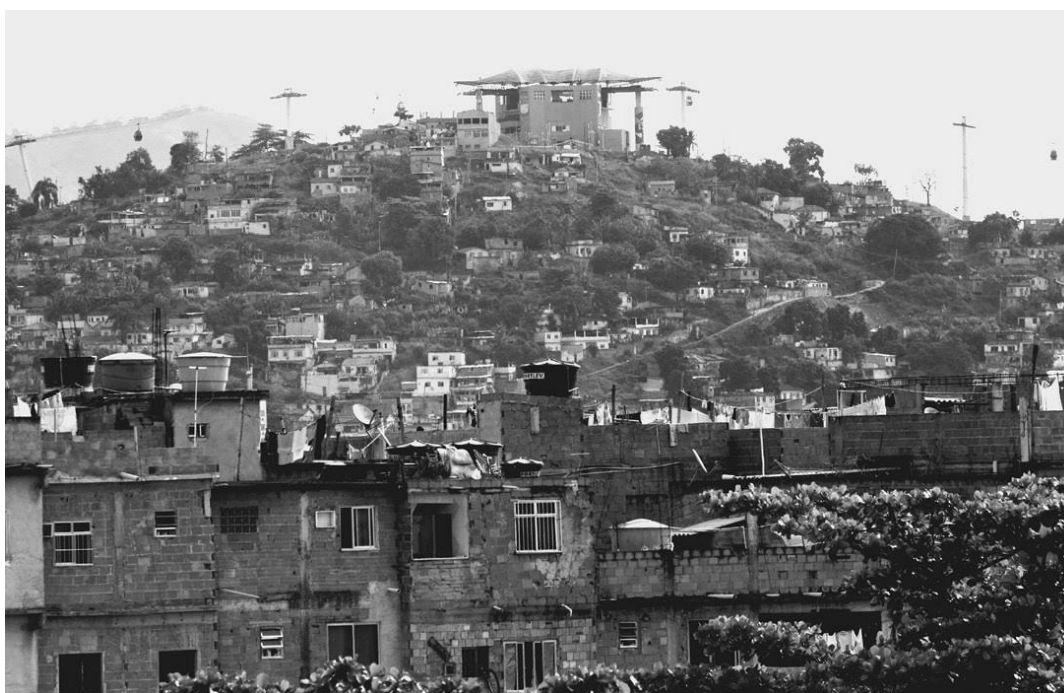
Figura 19 - Estação Adeus do teleférico vista da Linha Amarela. Foto do autor.
