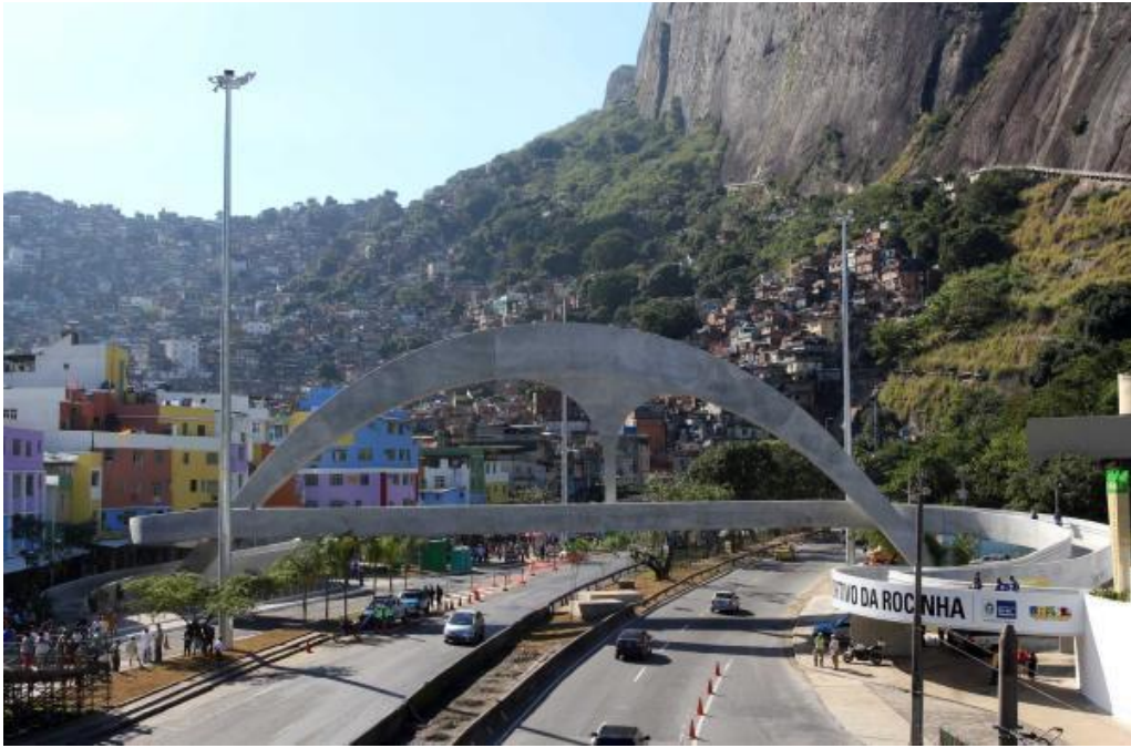
Figura 10 - Nova passarela da Rocinha, projetada pelo arquiteto Oscar Niemeyer. Fonte: http://www.rj.gov.br/ .
