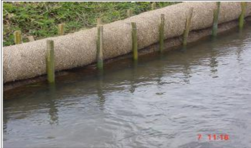
Figura 12.18: Fixação dos retentores com bambu.
