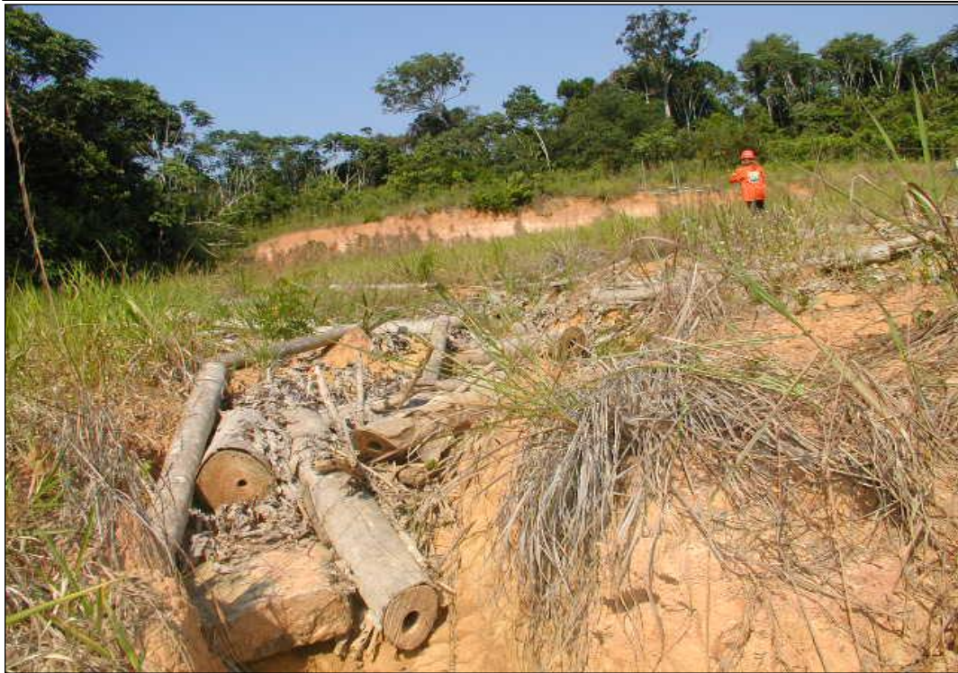
Figura 8.5: Toras de madeira não foram suficientes para a contenção de fluxos. Foto: Vieira (2005)
