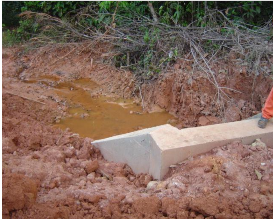
Figura 10.3: A elevada carga de sedimentos transportados causa assoreamento nos canais fluviais.
