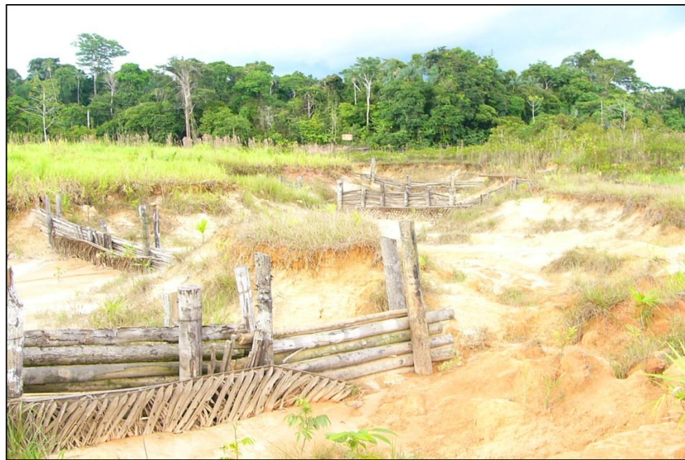
Figura 7.20: As barragens construídas na superfície interna da voçoroca propiciaram a redução do processo erosivo. A manutenção dos sedimentos foi efetuada com o auxílio de palhas que revestiram os intervalos entre as toras. A vegetação posta nas laterais também ajudou a conter os fluxos lineares.
