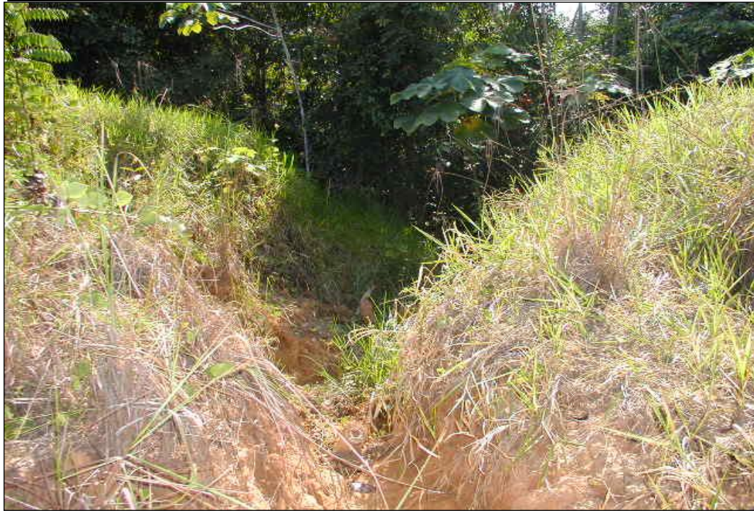
Figura 8.4: Incisões existentes na área de entorno. Foto: Vieira (2005)
