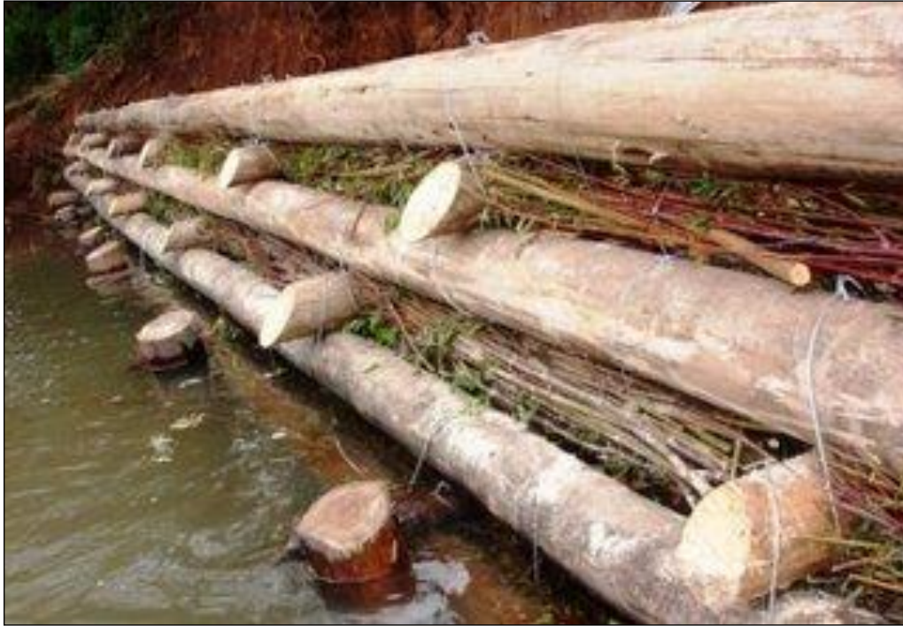
Figura 12.18.2: Palificada Dupla com preenchimento vegetal. Fonte: Deflor 2007
