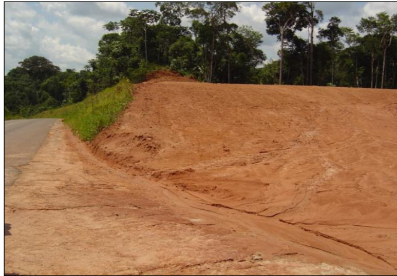
Figura 11.4: Encosta exposta por processo de terraplenagem
