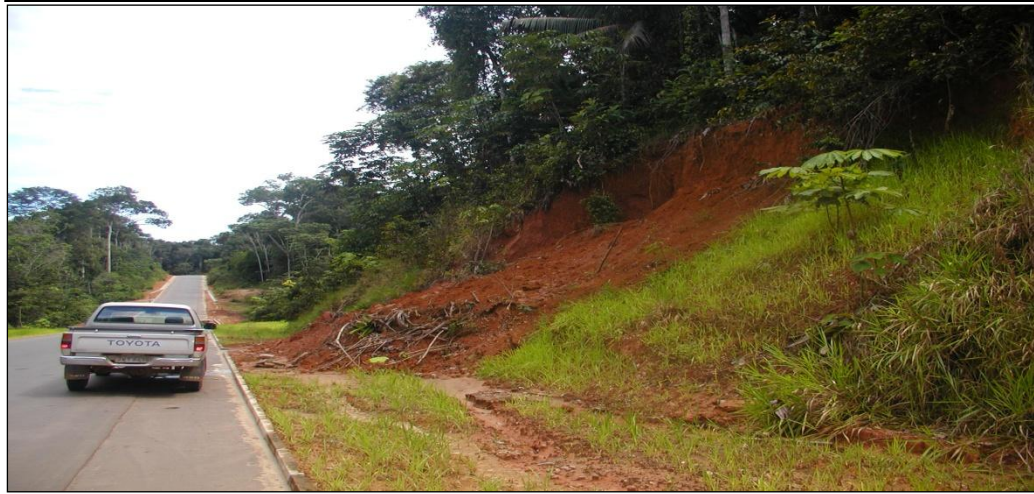
Figura 4.7: Perfil de solo exposto à ação erosiva. Foto: Vieira 2004.
