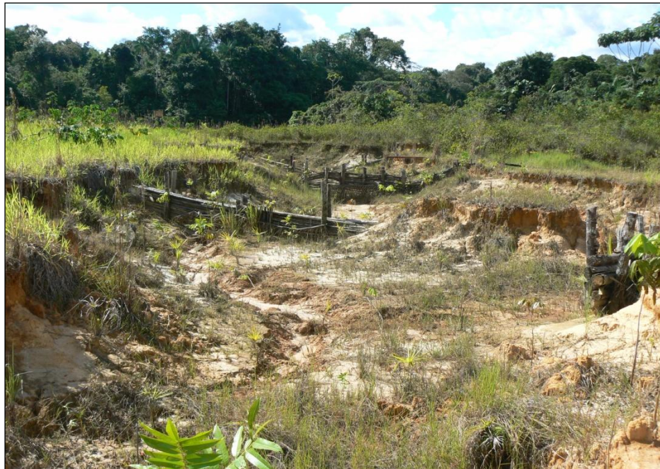
Figura 12.11: Porto Hélio depois da construção de barragens, os sedimentos são retidos no fundo e possibilitam o preenchimento da incisão. Os vegetais que foram plantados auxiliam na contenção.
