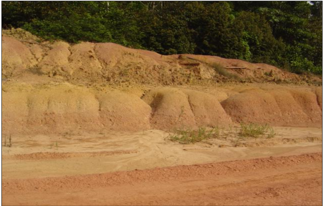
Figura 5.3: Os cortes realizados em taludes para a abertura de estradas que se direcionam até os poços de gás têm gerado processos erosivos que se iniciam pelo aparecimento de ravinas e evoluem para voçorocas nas laterais da estrada.
