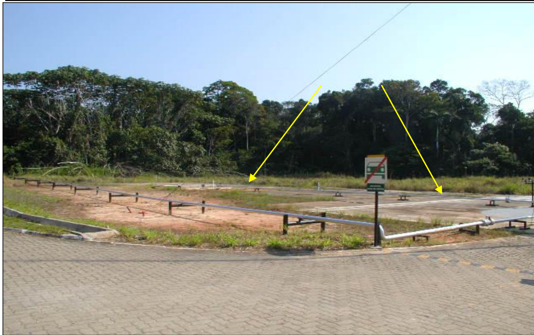
Figura 8.2: O recobrimento das áreas adjacentes aos poços. As setas indicam locais do entorno dessa área para onde os fluxos são direcionados provocando o surgimento de voçorocas. Foto: Aguiar (2005)
