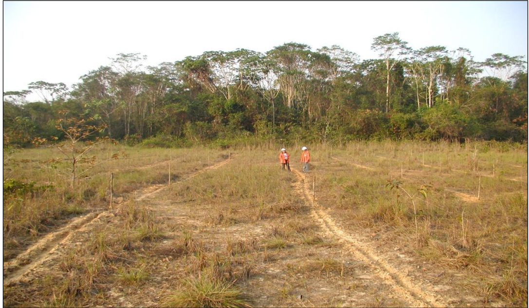
Figura 7.13: Marcação dos pontos de construção das canaletas em intervalos de seis metros de distância correspondente às cabeceiras.
