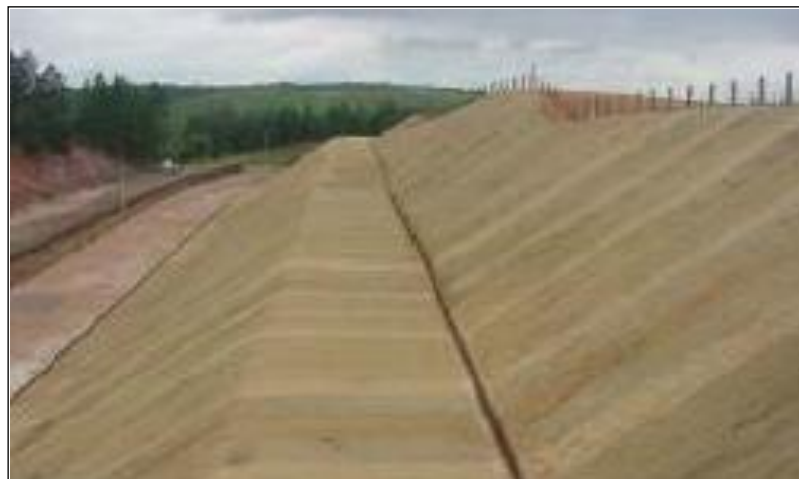
Fig.11.4.2: Revestimento de encosta com biomanta
