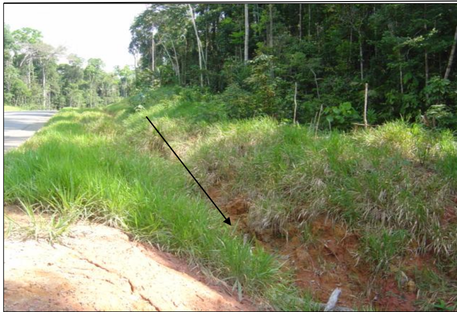
Figura 11.3: Exemplo de fluxos concentrados nas laterais das estradas, provocando o aparecimento de sulcos que evoluem para voçorocas. O material transportado por estas incisões é direcionado para os rios que cortam as estradas.
