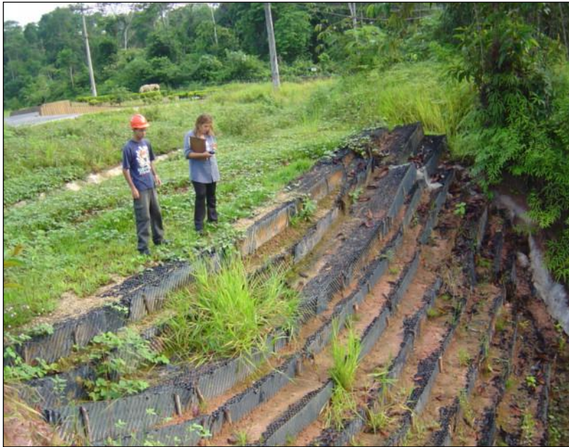
Figura 12.2: O uso de telas de plástico na vertente. Fotos: Vieira (2004)
