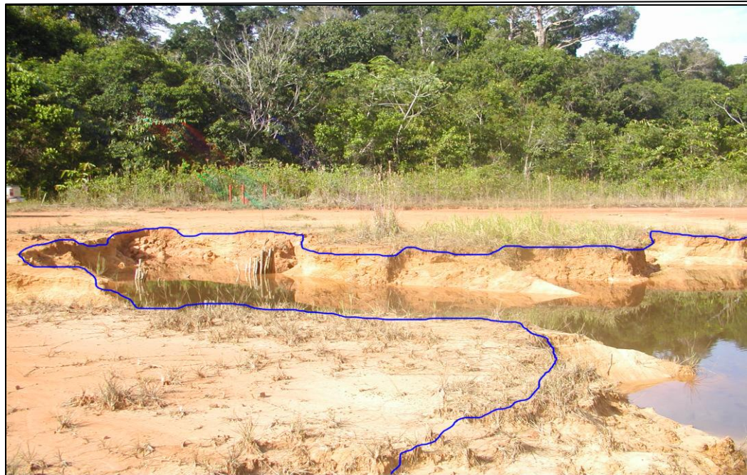
Figura. 7.16: A mesma voçoroca na localidade do Porto Hélio em Junho de 2005. A interação de fluxos associada à contribuição do volume de água do rio Urucu proporciona a enchente dentro da incisão, configurando-se um pequeno canal de 1ª ordem.
