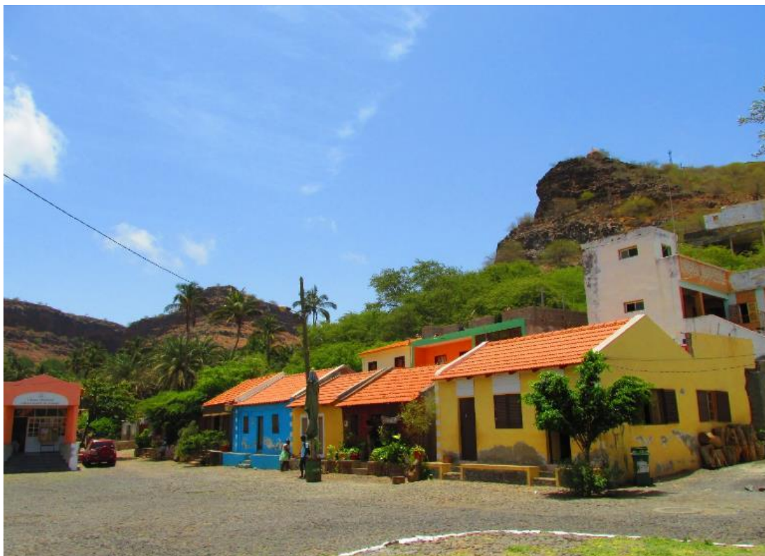
Figura 9: Casas com telhados recuperados no centro da Cidade Velha.
