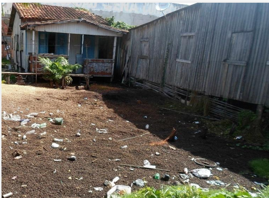
Figura 80 - Depósitos gárbicos de origem natural como caroços de açaí, utilizados pela população de baixa renda para aterramento de terrenos. Bairro da Terra Firme.
