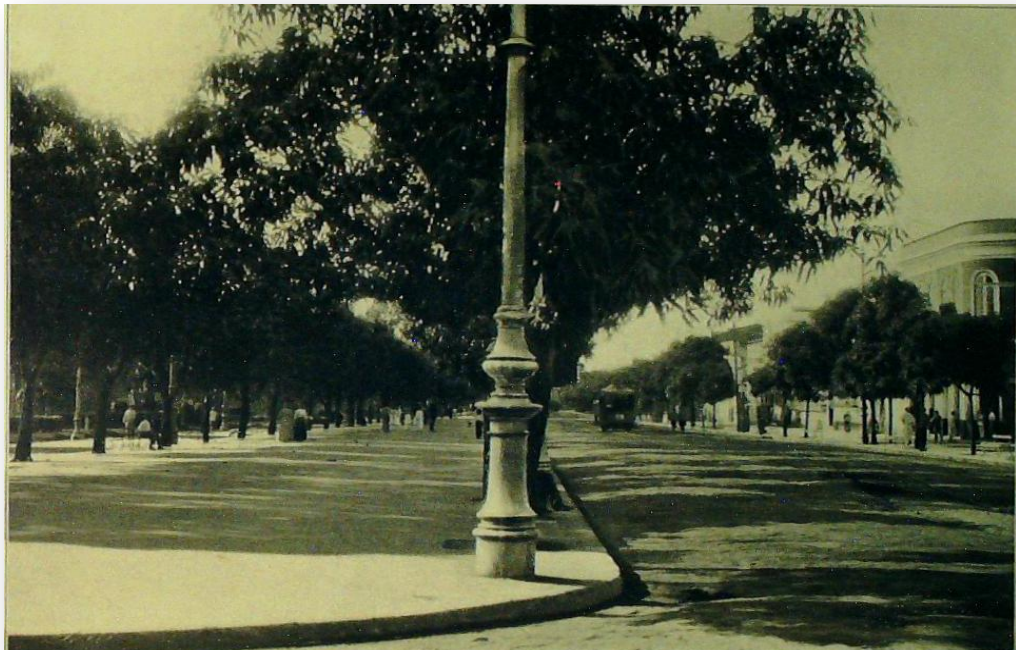
Figura 31 - Calçamento do entorno da Praça da República.
