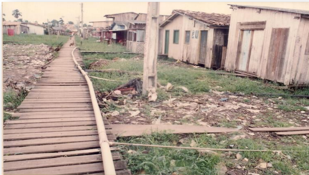
Figura 61 - Aterramento de várzeas recentes do Tucunduba com material de origem antrópica como o lixo. Bairro da Terra Firme.
