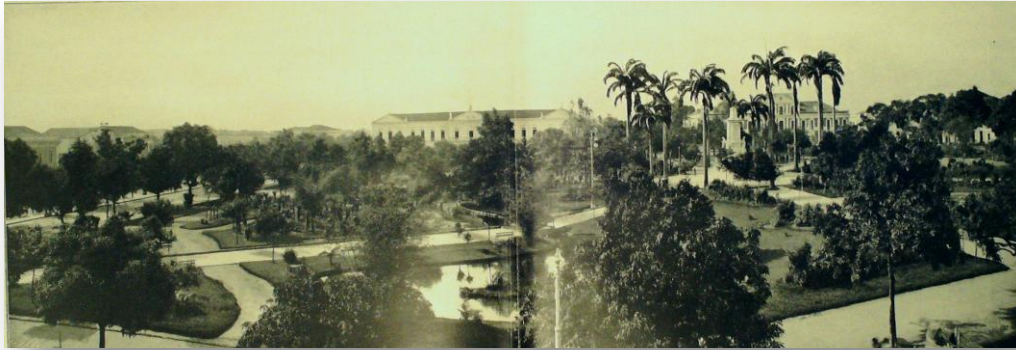
Figura 32 - Praça da Intendência, ao fundo Largo do Palácio.
