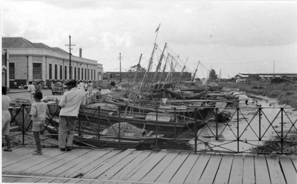
Figura 41 - Igarapé das Almas por volta de 1935, na maré baixa.
