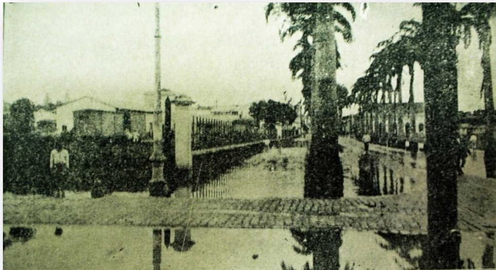
Figura19 - Estrada de São José durante a enchente de maré de 1899.
