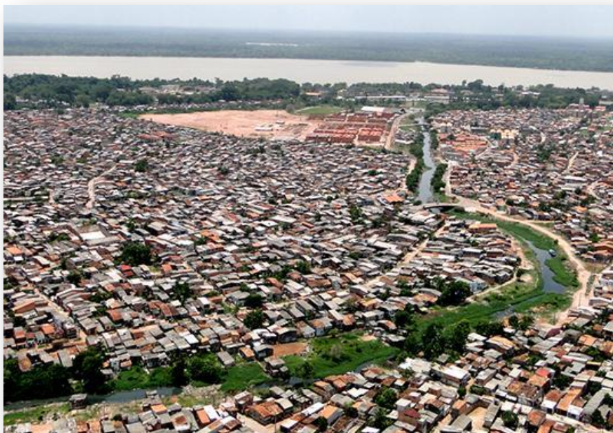
Figura 79 - Planície Tecnogênica do Tucunduba, em áreas de grande adensamento horizontal e precário.
