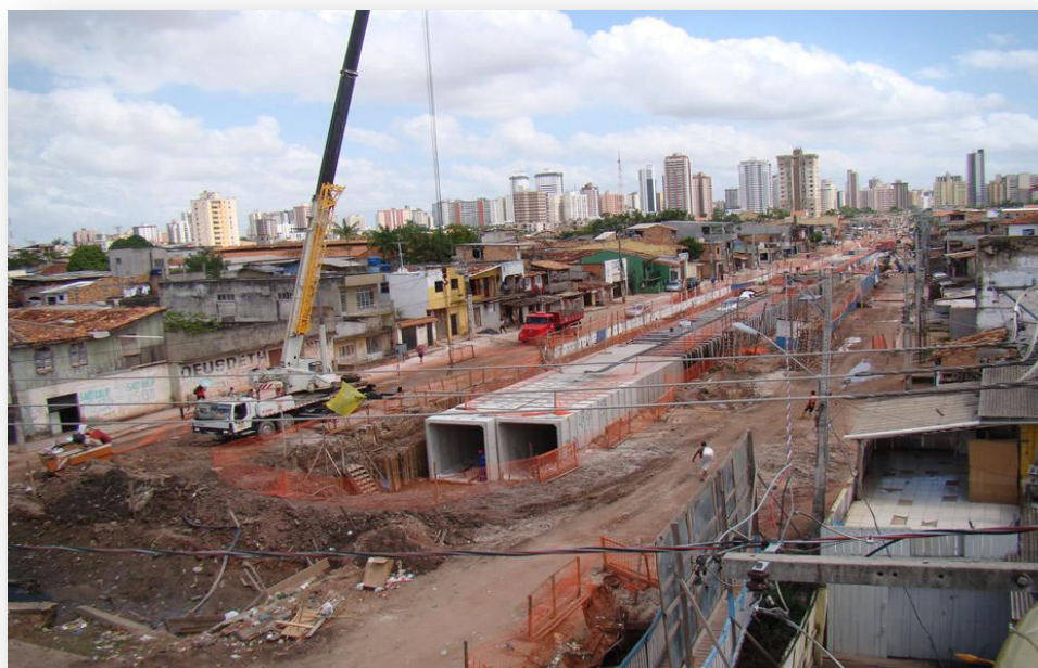
Figura 91 - Canal da Caripunas durante as obras de implantação de sistemas de galerias. Bacia da Estrada Nova
