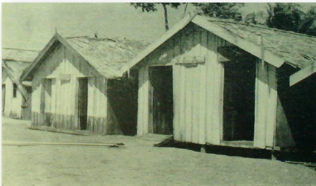
Figura 59 - Moradias de madeira em áreas aterradas pela própria população, em ruas sem pavimentadas em várzeas de ocupação recente. Bairro da Condor.
