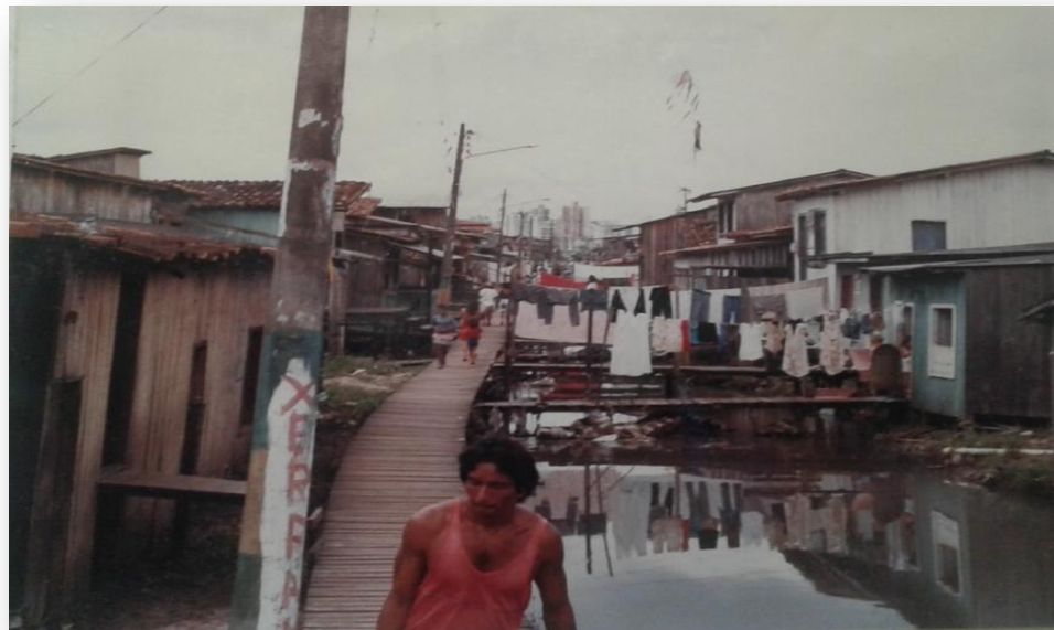
Figura 52 - Canal da Visconde de Inhaúma bairro da Pedreira, antes da macrodrenagem. Presença de ocupações informais e ausência de infraestrutura urbana. Bacia do Una.
