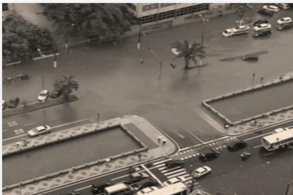
Figura 89 - Registro de Transbordamento do Canal da Doca de Souza Franco após forte chuva ocorrida em 03 de Fevereiro de 2014.
