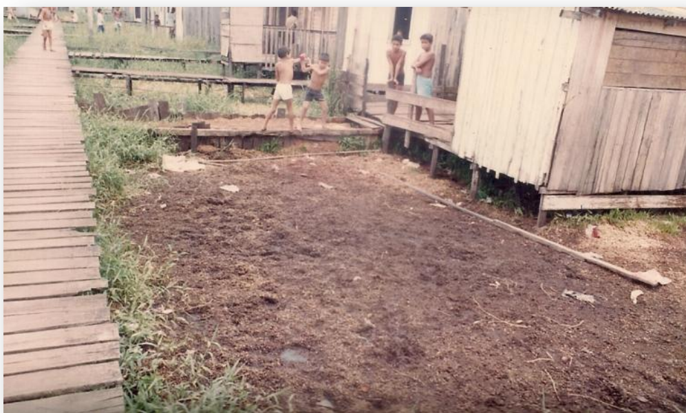
Figura 62 - Aterramento da várzea recente do Tucunduba com material de origem orgânica como serragem.
