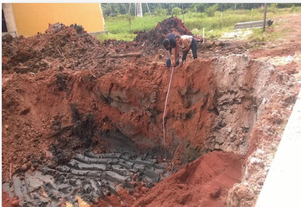
Figura 83 - Material espóico utilizado para aterramento de solos argilosos na área de expansão urbana da UFPA
