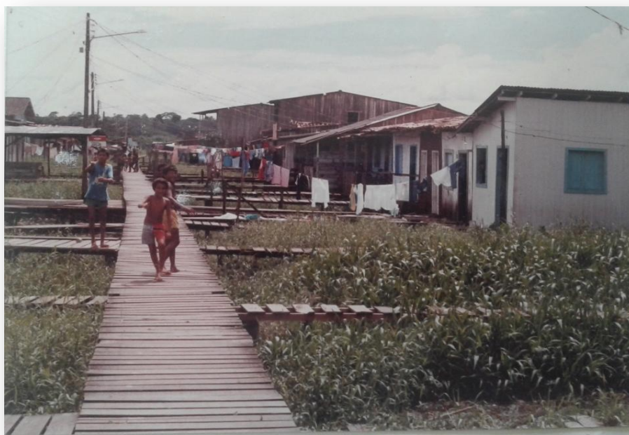
Figura 55 - Estivas são pontes de madeira construídas pela população para a circulação em áreas de ocupações informais Várzea do Tucunduba.
