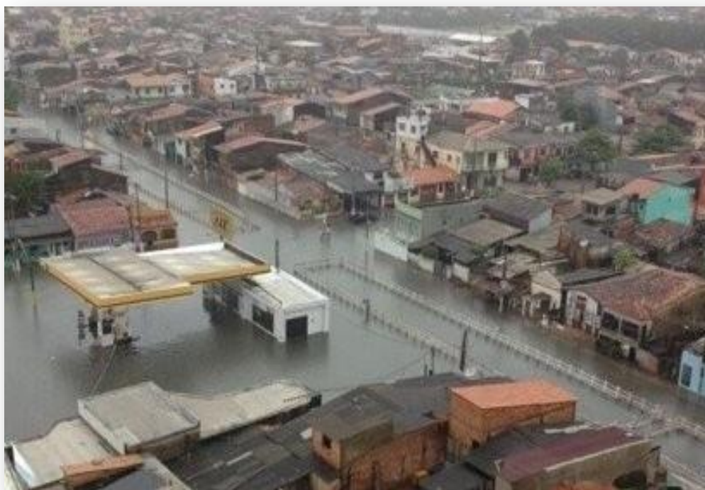
Figura 92 - Transbordamento do canal da 14 de março, Bacia da Estrada Nova.
