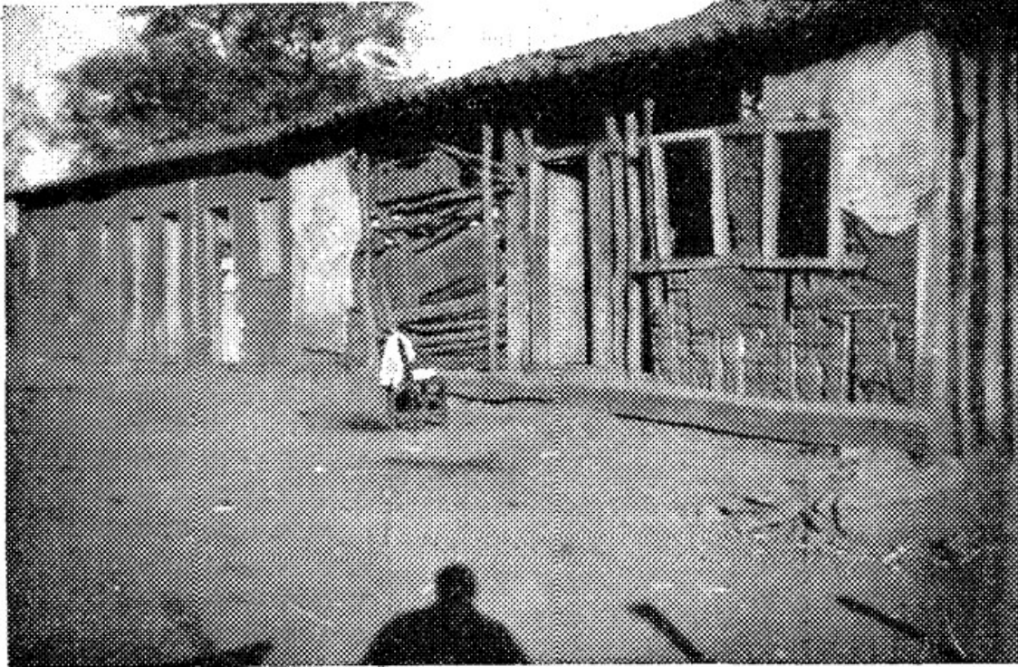
Figura 51: “Vemos nesta foto o estado de pobreza da zona ora estudada. Esta casa está caindo como se vê e seu proprietário, pobre lavrador, não conta com recursos para os simples consertos. A construção, em taipa, com cobertura de telhas, é característica. Trechos de paredes, caiados, mostra a proximidade do calcáreo”. Fonte: PEREIRA, G., 1945, p. 55.
