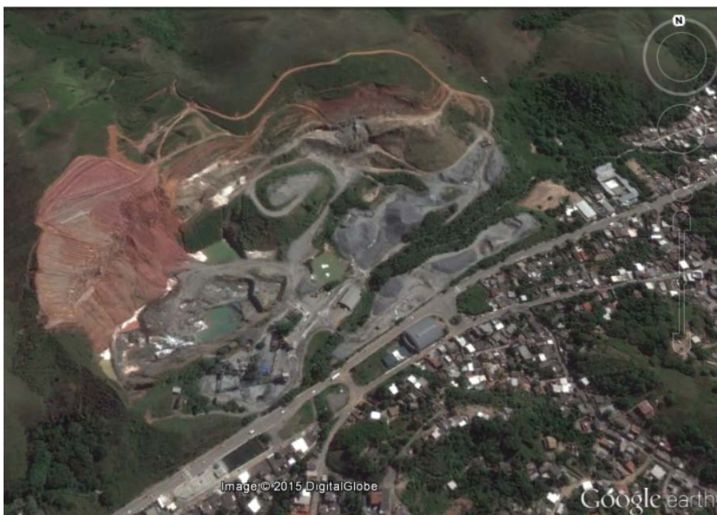
Figura 15- Visualização vertical, por imagem de satélite do Google Earth, do Terreno Tecnogênico Misto – Unidades Sobrepostas identificado no Setor Leste de Volta Redonda (RJ), produzido por uma mineração de agregados (brita). Google Earth – Acesso em 13/12/2015
