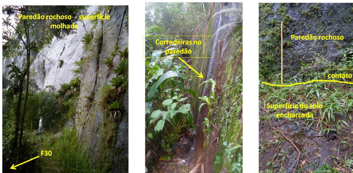
Figura 65: Contato paredão rochoso e base da encosta com depósito de tálus próximo a F30.
