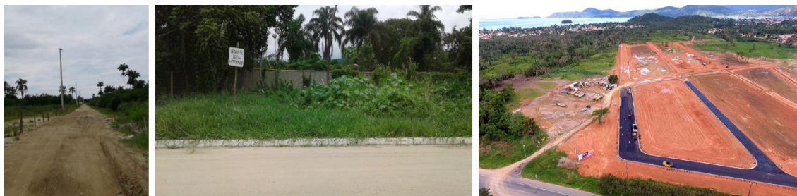
Figura 83: Implantação de postes na nova avenida de Jabaquara, lote a venda, e loteamento Jardim Porto das Canoas.
