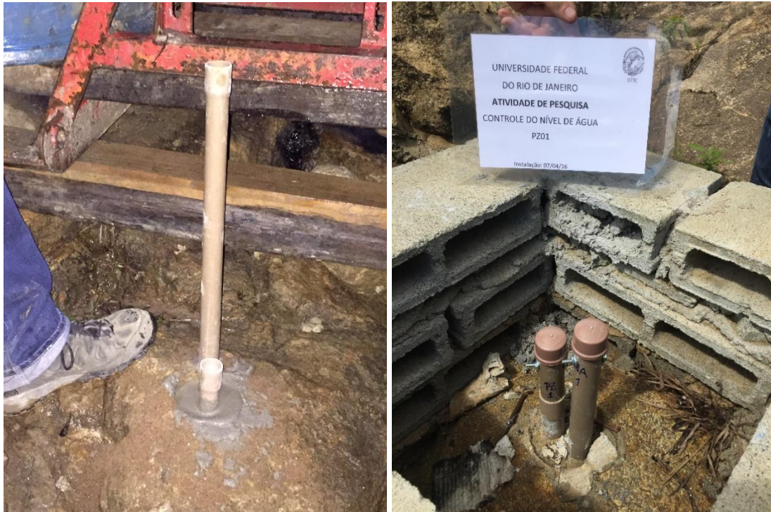
Figura 34: Confeção e acabamento dos poços e instalação dos piezômetros e níveis de água.
