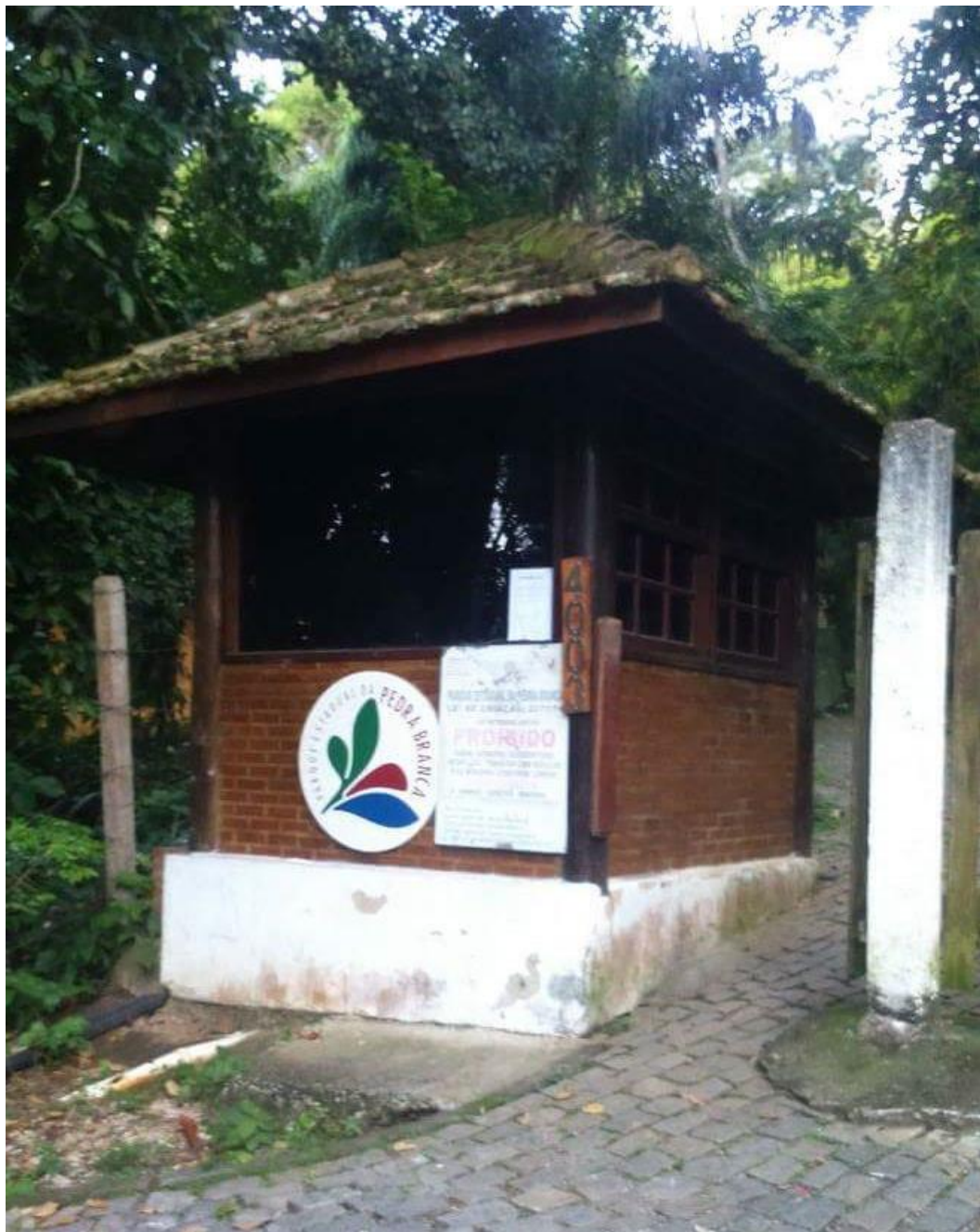
Figura 6 - Guarita na entrada do Parque pela Estrada Pau da fome
