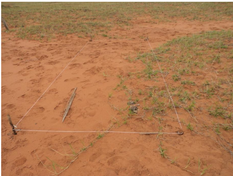
Figura 76. Delimitação das parcelas em 2 metros de largura por 5 metros de comprimento para posterior aplicação do geotêxtil (manta orgânica) nas laterais e em cobertura. Foto: C.L. Vieira (Maio, 2015).
