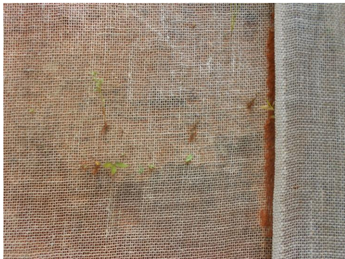
Figura 68. Verificação de plântulas sobressaindo a trama de biotêxtil aplicado sobre o talude de ravina. Foto: C.L.Vieira (Novembro, 2014).
