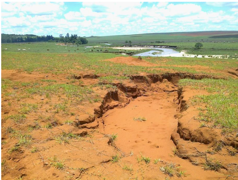
Figura 133. Ravina transversal ao curso de água e com dinâmica conectada à rede de drenagem. Foto: C.L. Vieira (Março, 2016).
