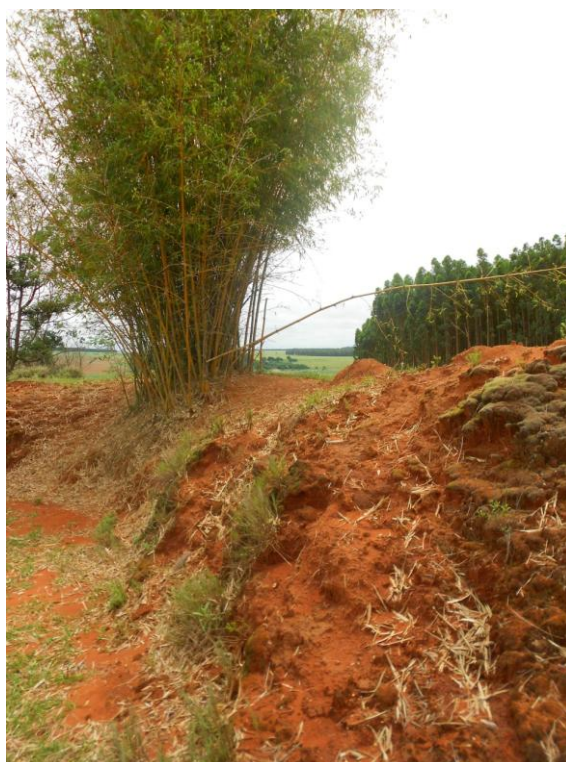
Figura 51. Início do setor de ravinas localizado à direita, sentido montante-jusante, terço final da propriedade, meio fortemente instável. Foto: C.L.Vieira (Novembro, 2014).
