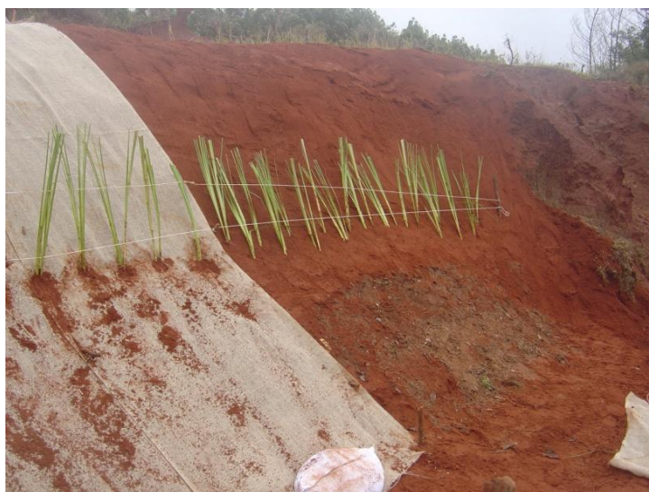
Figura 70. Plantio de mudas de capim vetiver em talude de ravina remodelado. Verificação quanto ao potencial de sobrevivência às condições edafo-climáticas de São Francisco de Assis. Foto: C.L. Vieira (Junho, 2014).
