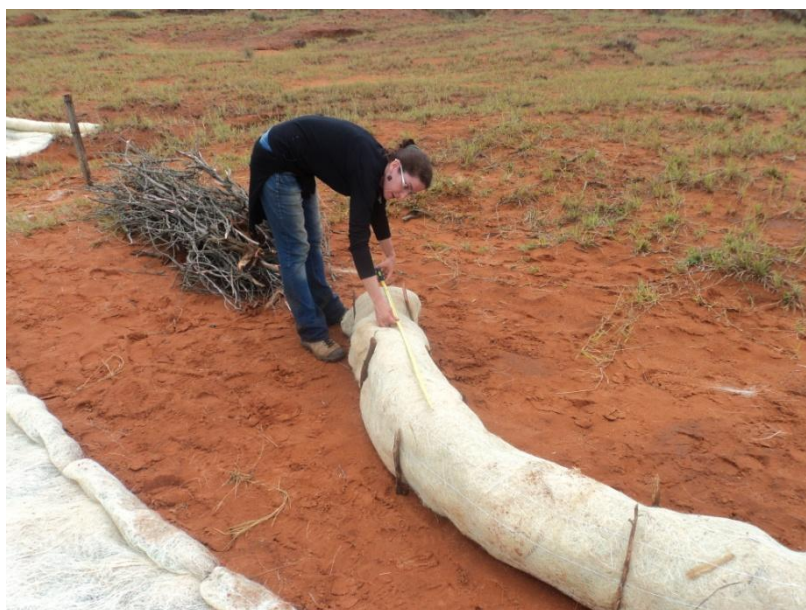
Figura 89. Fixação da estrutura aberta para a estimativa de erosão e aferição de suas dimensões finais. Foto: A.G. Goulart (Maio, 2015).
