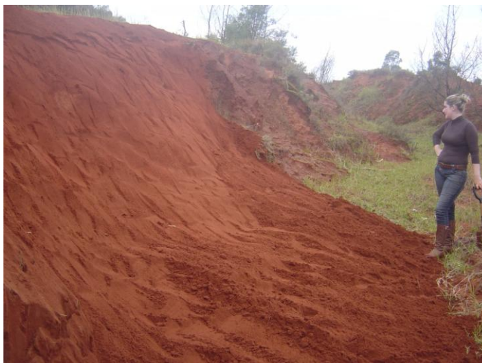
Figura 47. Remodelação do talude para aplicação de topsoil , plantio de mudas de capim Vetiver e cobertura com biomanta. Foto: C.L.Vieira (Junho, 2014).
