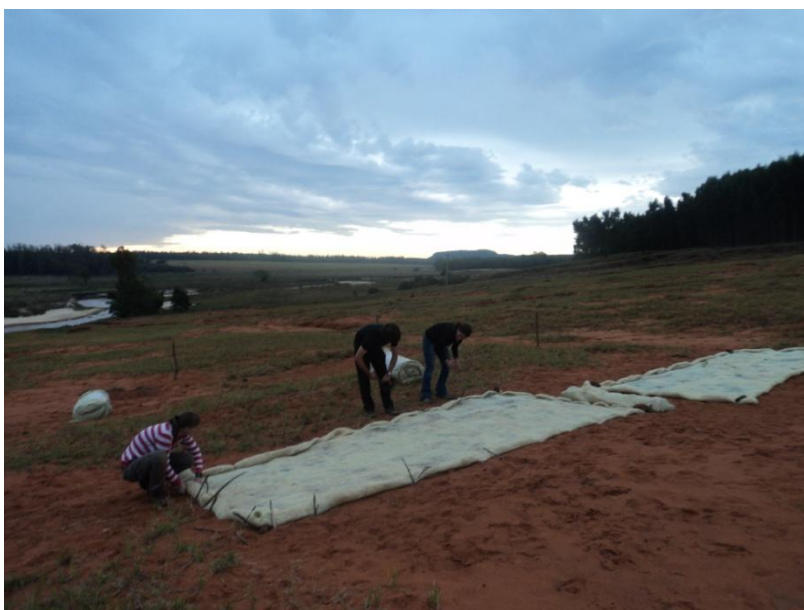
Figura 77. Aplicação do geotêxtil (manta orgânica) para o estabelecimento das UAs na Área Experimental I (AE-I). Foto: C.L. Vieira (Maio, 2015).
