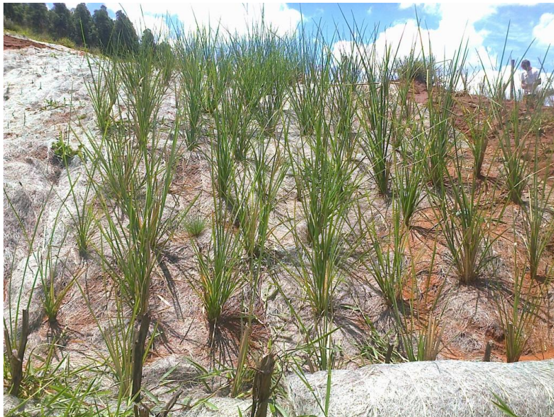
Figura 102. Parcela de capim Vetiver com cobertura de geotêxtil de sisal. Visada a partir da base. Foto: C.L. Vieira (Dezembro, 2015).
