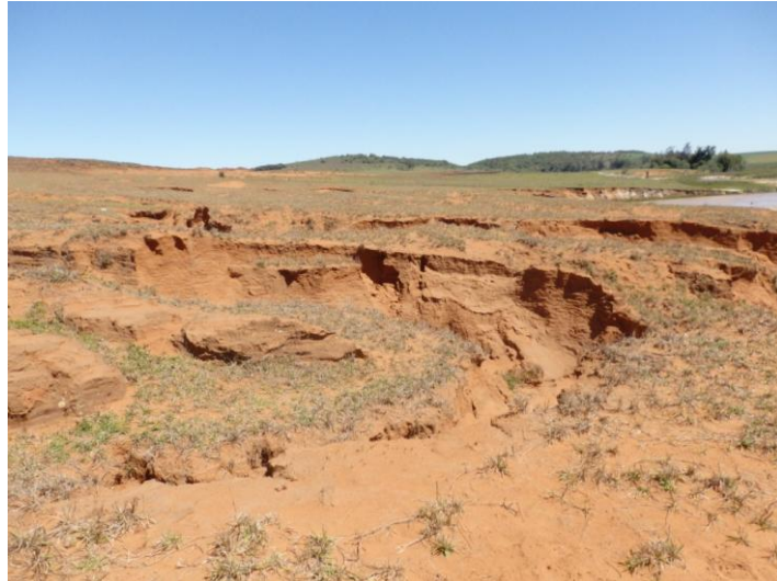
Figura 54. Área superficial adjacente à margem esquerda do curso de água, apresentando uma significativa quantidade de ravinas ativas conectadas à rede de drenagem. Foto: C.L.Vieira (Dezembro, 2015).
