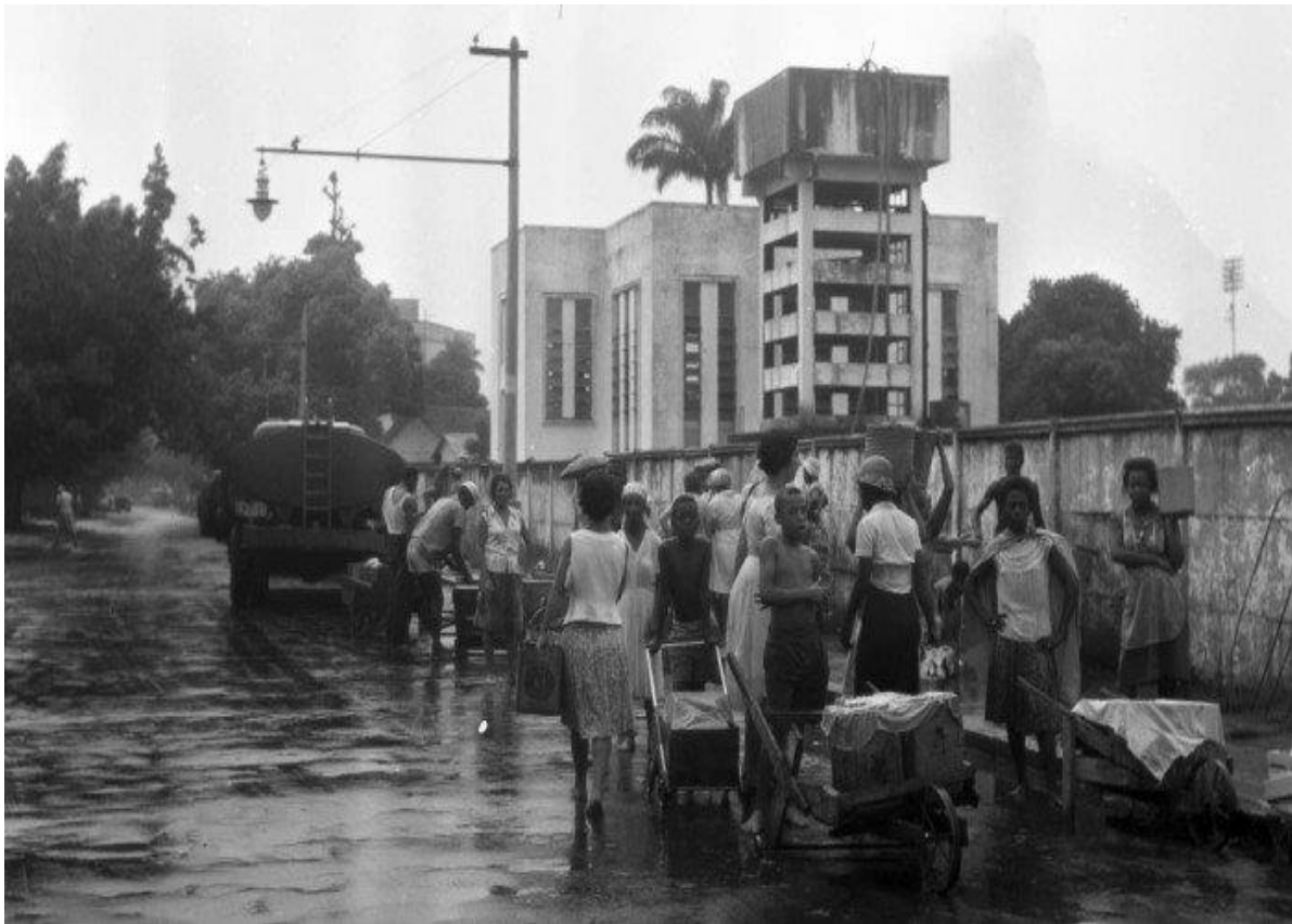
Figura 5 – Populares fazem fila para abastecimento de água com carro-pipa na estação elevatória do Leblon (Agência O Globo, 06/03/1961).
