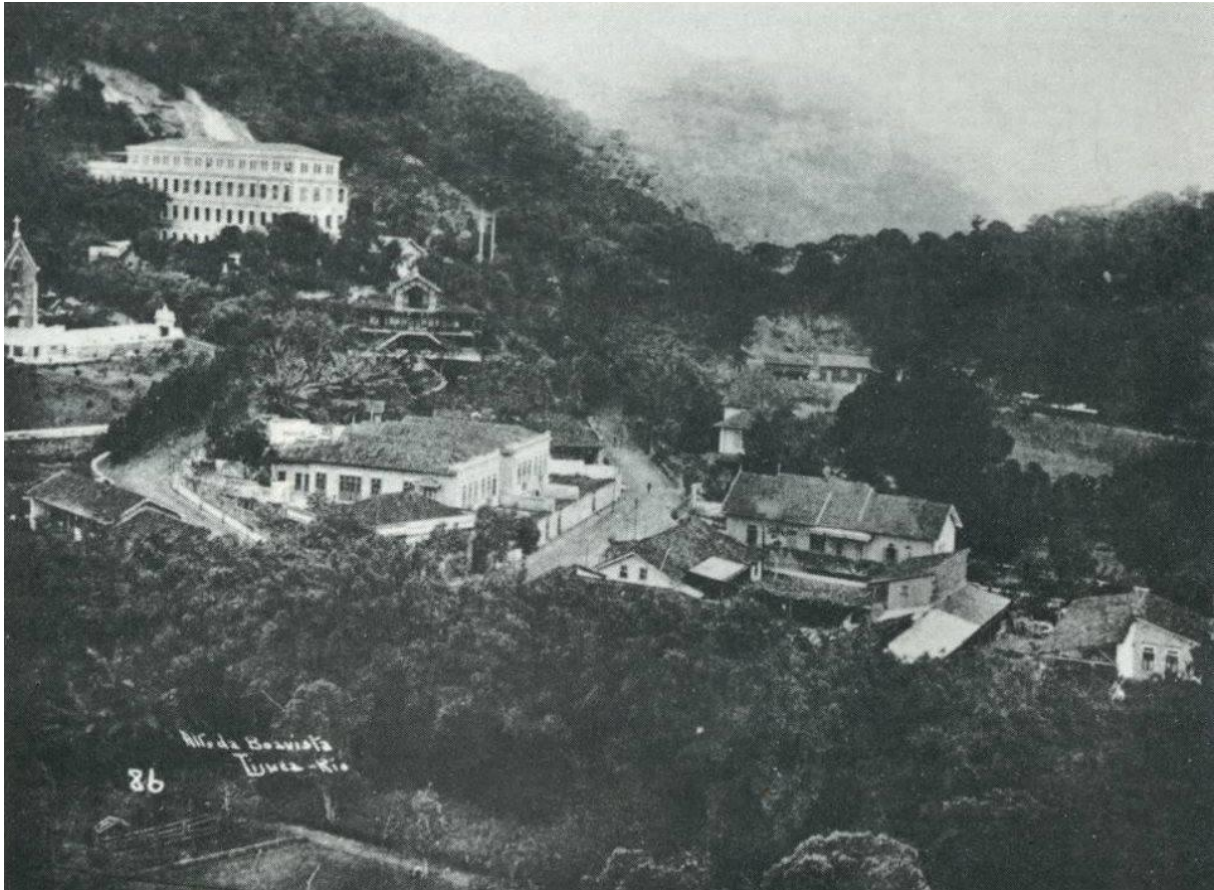
Figura 8 – Panorama do Alto da Boa Vista em princípio do séc. XX (Augusto Malta, fotografia de aprox. 1920).
