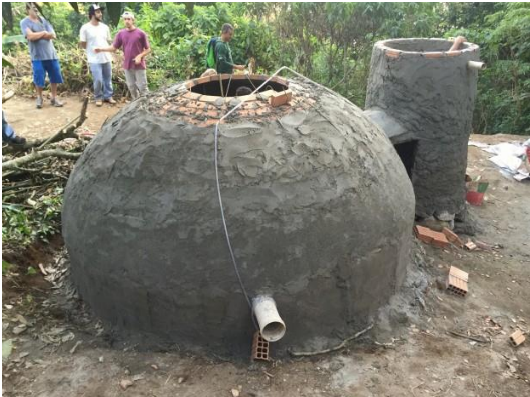
Figura 20 – Construção do biodigestor para o tratamento de esgoto (obtida no site da associação de moradores do Vale Encantado, set. de 2015).
