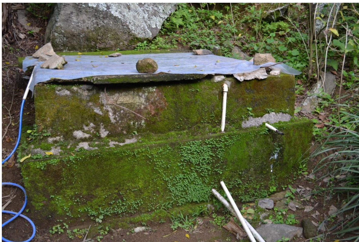
Figura 19 – Captação de nascente na favela Vale Encantado. Foto: Eduardo Bayer Knopman (2016).
