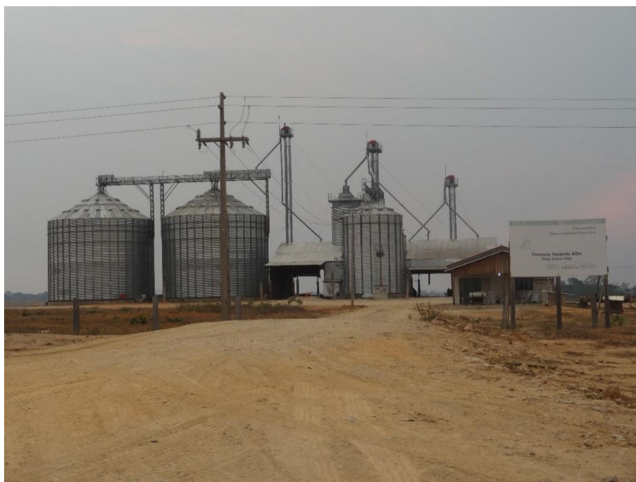
Figura 21 Silos em construção as margens da BR-163 em Novo Progresso.
