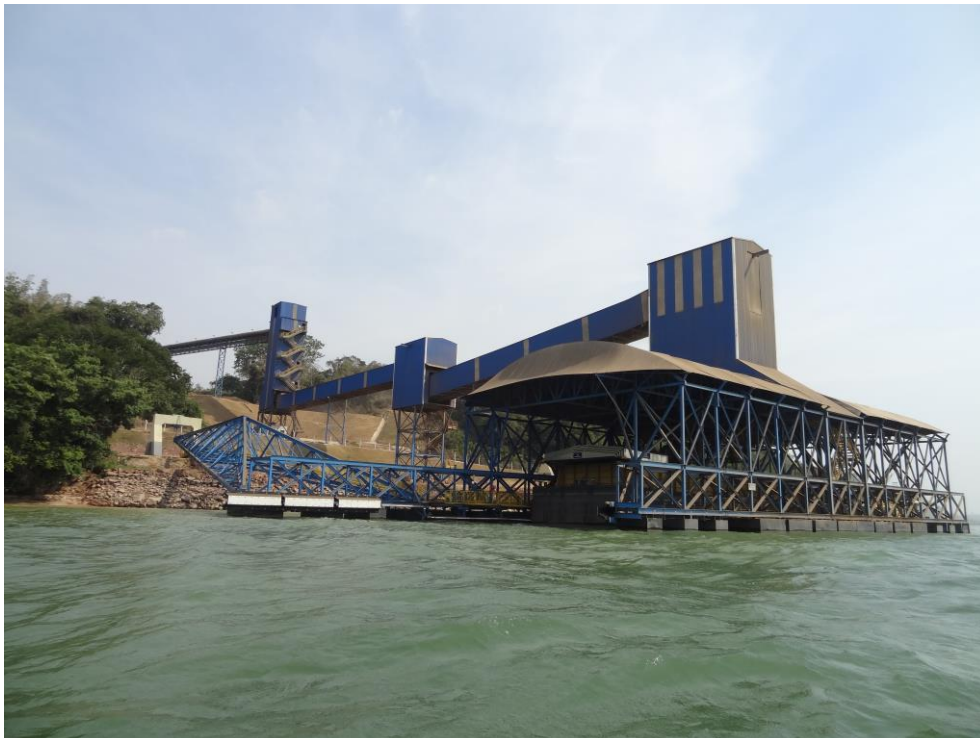
Figura 10 Estação de transbordo da Bunge em Miritituba
