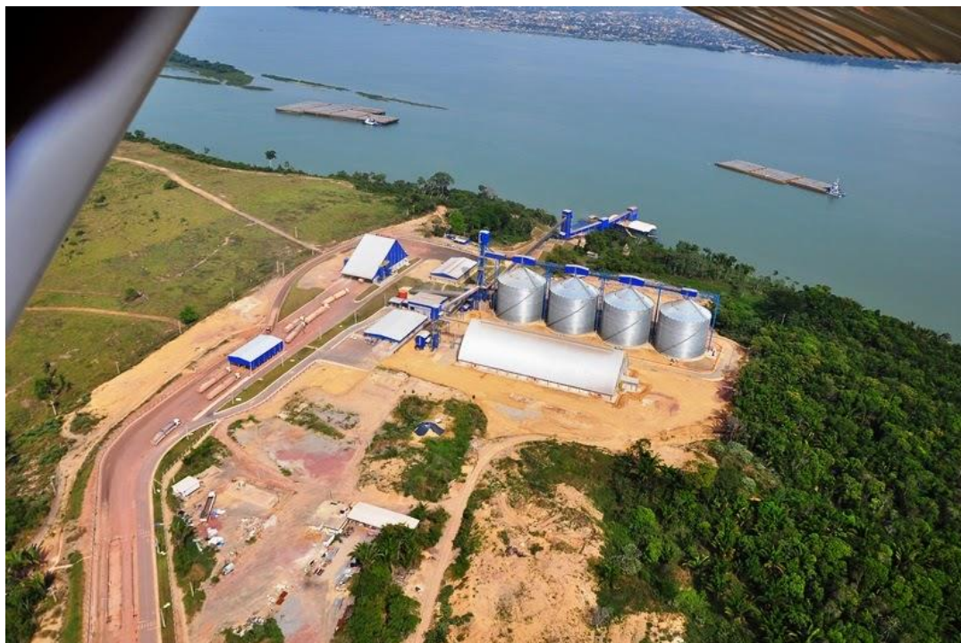
Figura 8 Estação de transbordo da Bunge em Miritituba
