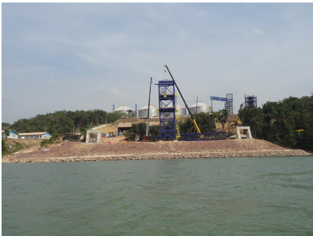
Figura 13 Estação de transbordo em construção da Cargill em Miritituba
