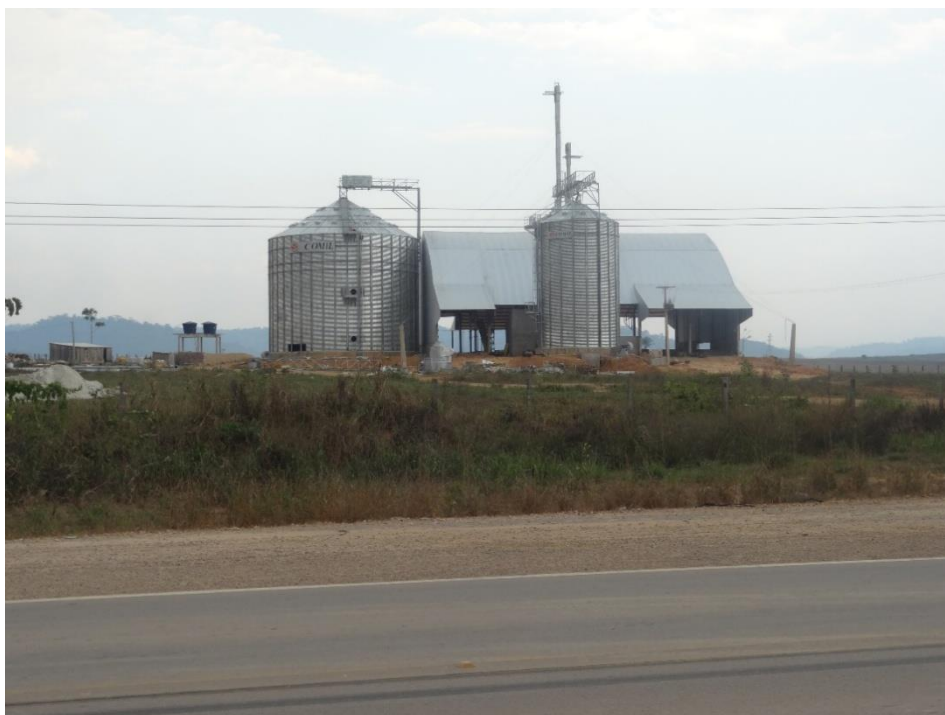
Figura 20 Silos em construção as margens da BR-163 em Novo Progresso.
