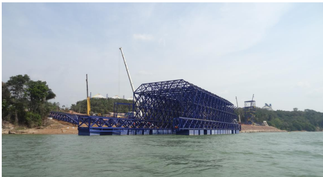
Figura 12 Estação de transbordo em construção da Hidrovias do Brasil em Miritituba
