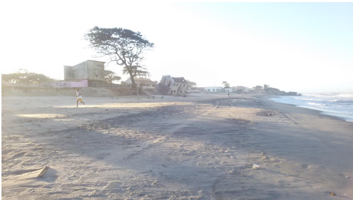
Imagem 3.1 - Orla em ruínas. Janeiro de 2016.
