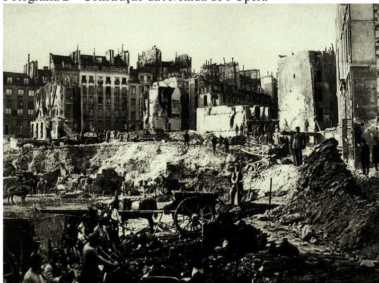
Fotografia 2 – Construção da Avenida de l'Opéra
