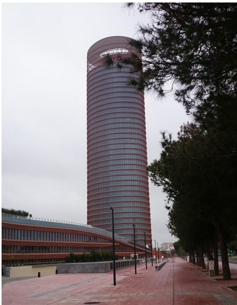
Fig. 16 41 – Aspecto da Torre Sevilla em abril de 2015, já praticamente pronta. (trabalho de campo realizado em 12/02/2016)
