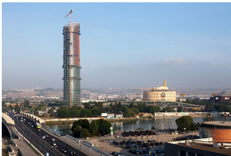
Fig.31 – Perspectiva de visualização da Torre Sevilla a partir do lado leste do rio Guadalquivir, eixo zona sul da Ilha da Cartuja. Em destaque, edifício Torre triana e o World Trade Center de Sevilla. 131
