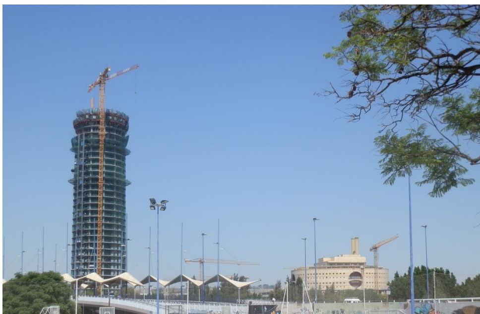
Fig. 52 – Andamento da construção da torre em junho de 2012, (Fotografia do próprio autor em trabalho de campo - 15/06/2012)
