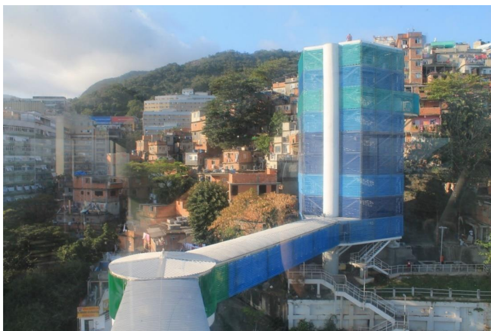
Figura 27 – Vista dos morros e da segunda torre a partir do Mirante da Paz
