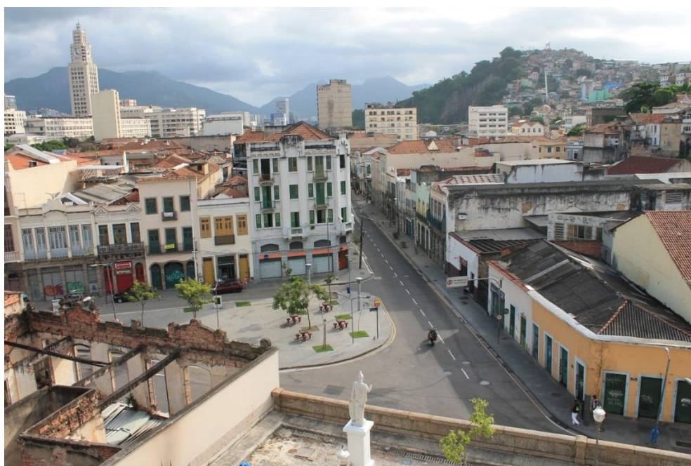
Figura 43 – Central do Brasil, Morro da Providência, Jardim do Valongo e entorno vistos do Mirante do Valongo
