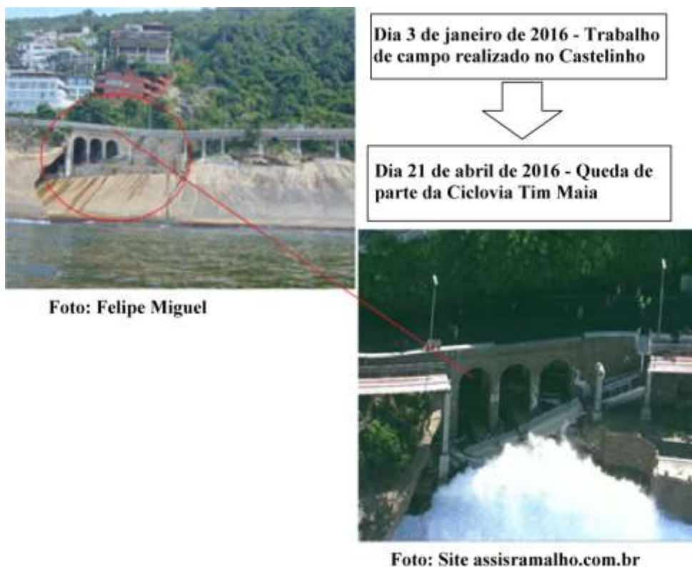
Figura 110: Parte da ciclovía destruída por lavagem das ondas no L16, o Castelinho.
