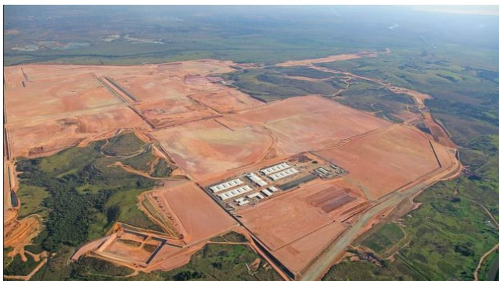
Figura 1: Obras de terraplanagem e construção dos prédios de fiscalização do Comperj. devido à presença de lençóis freáticos em cotas elevadas, foi necessária a realização do rebaixamento destes lençóis. Fonte: <https://www.flickr.com/photos/pacgov/6938887493>. Data de acesso: 22/12/2017.
