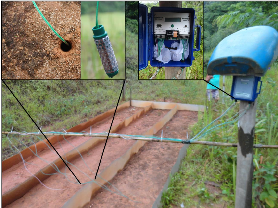
Figura 32. Visão geral das parcelas de erosão, salientando a instalação do sensor de umidade do solo e o datalogger . Foto: Leonardo S. Pereira (2015).
