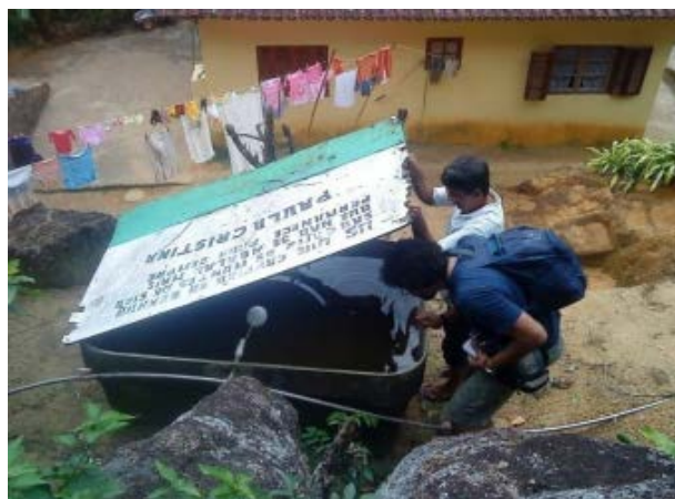
Figura 28 – Reservamento adequado de água no Pouso da Cajaíba. Fonte: FIOCRUZ, 2016
