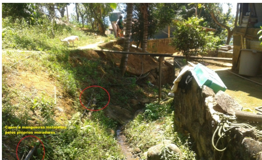
Figura 4 - Foto de captação de água realizada pelos moradores da Praia do Guerra. O círculo vermelho chama atenção para as "macarronadas", prática comum na zona costeira e rural de Paraty. Fonte: Acervo pessoal.
