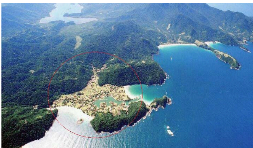
Figura 14 - Condomínio Laranjeiras, na zona costeira de Paraty. À direita a praia do Sono, e ao fundo da imagem o Saco do Mamanguá. A área do condomínio fica dentro da APA Caiuruçu e nas fronteiras do Parque Nacional da Bocaina e da Reserva da Joatinga. Fonte: Acervo público, Google, 2016.
