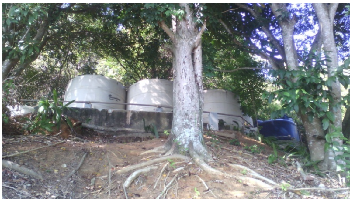
Figura 35 - Caixas d'água instaladas sem autorização por um morador de segunda residência. Fonte: Acervo pessoal.
