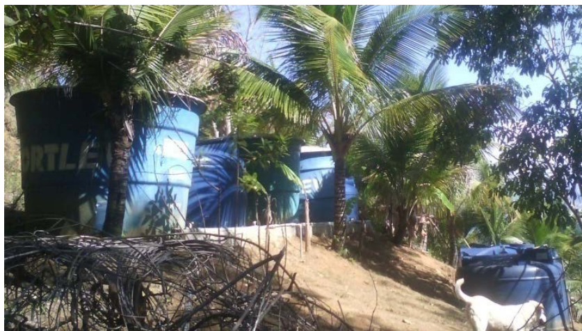
Figura 36 - Caixas d'água instaladas sem autorização por um morador de segunda residência. A fotografia evidencia como a vegetação nativa está sendo substituída por palmeiras. Fonte: Acervo pessoal.
