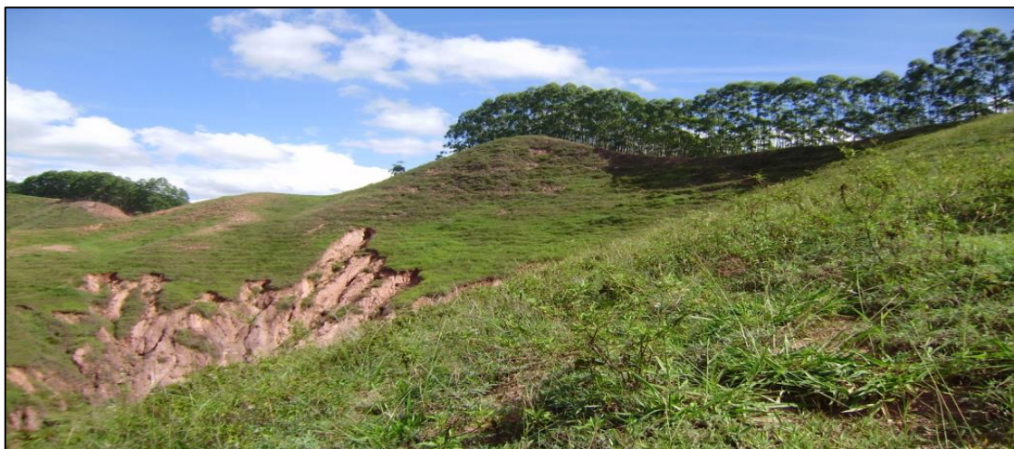
Figura 42: Voçoroca 2 avançando em direção ao divisor de drenagem. Na vertente oposta encontra-se os plantios da Fazenda Caximonan da empresa Fibria, introduzidos no ano de 2004 (Foto: Sato, 2012).
