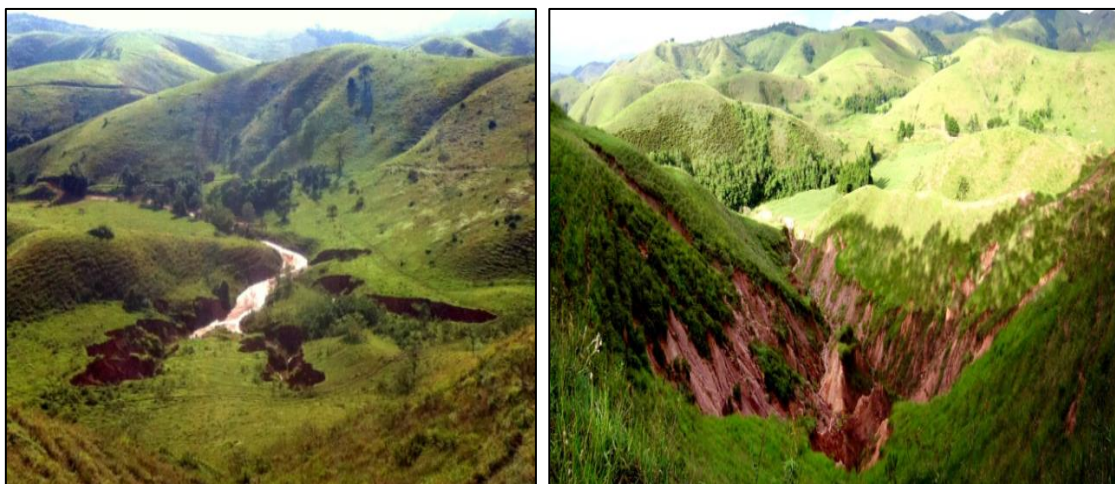
Figura 29 – Voçoroca 01 (esquerda) retrabalhando os depósitos de fundo de vale (rampas). Voçoroca 02 (direita) avançando para alta encosta (próximo ao divisor de drenagem) (Fotos – Sato,2012).
