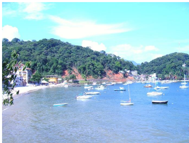
Figura 1: Exemplo de Movimento Gravitacional de Massa (MGM) ocorrido na Estrada do Contorno (Angra dos Reis, RJ), Foto: E. POCIDONIO (Janeiro/2010).
