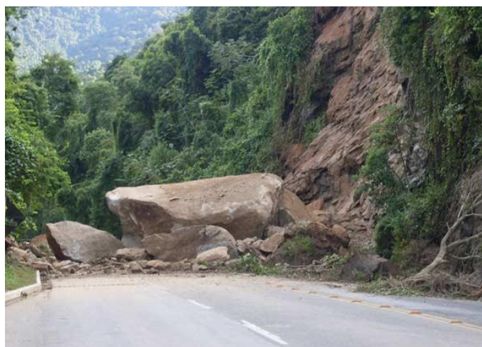
Figura 2: Queda de blocos ocorrido na madrugada do dia 13 de abril de 2010 interditando a rodovia Rio-Santos (BR-101) nos dois sentidos no município de Angra dos Reis (Foto: Rafael Souza Diniz/VC no G1). Fonte: http://g1.globo.com/VCnoG1/0,,MUL1568061-8491,00.html .
