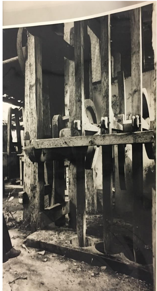
Fotografia 16 – Pilão Hidráulico, Cáceres, MT. 1977
