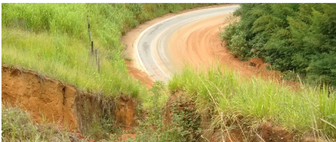
Figura 71 – Vista a partir da lateral esquerda da voçoroca A, com a estrada tomada de sedimentos. Foto: Diego Janoti Suarez (2018).
