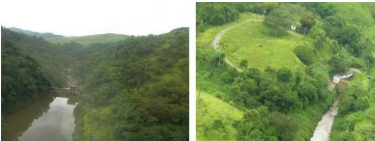
Figura 6 – Barragem no rio Piraí, à esquerda, e entrada do Túnel de Tócos, à direita. Fonte: INSTITUTO TERRA, 2008.
