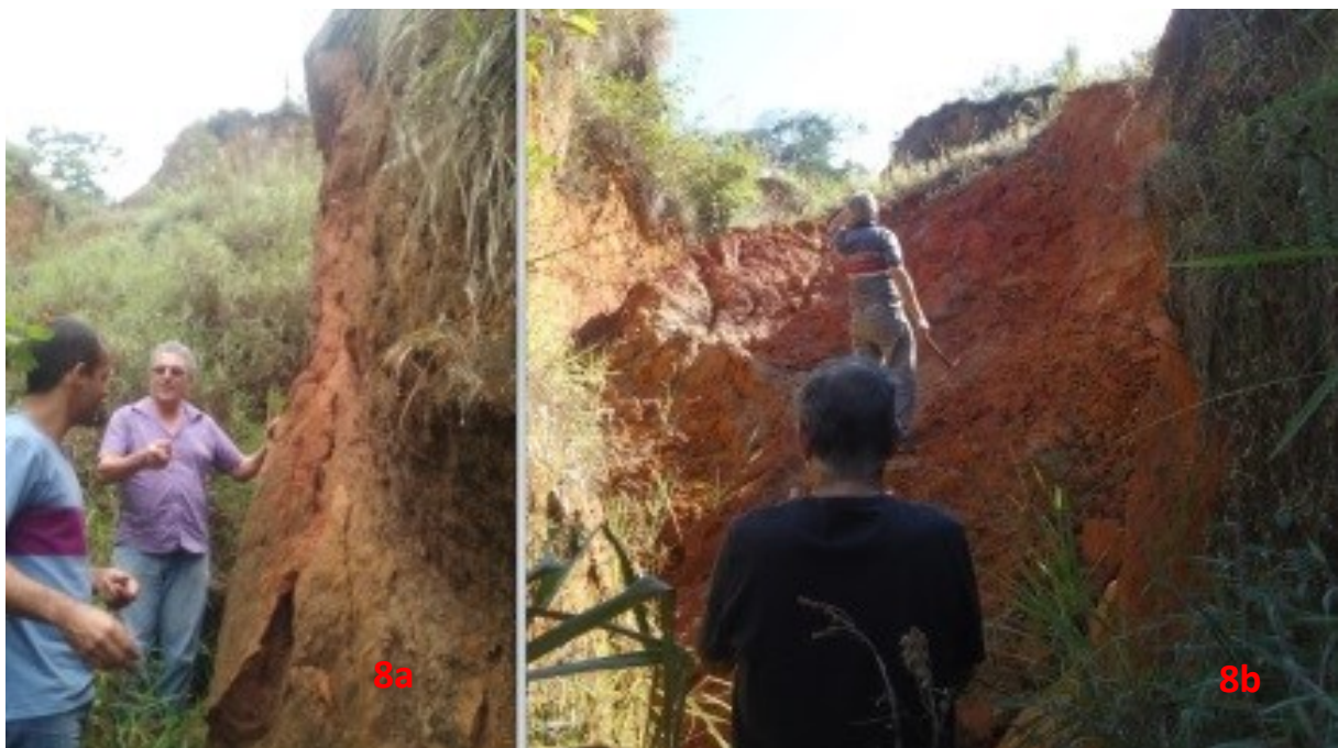
Figura 7 – Visão na saída da voçoroca em dois momentos: (a) dezembro de 2015, com certa estabilidade; (b) maio de 2016, com a feição erosiva bastante alterada. Foto: Hugo A. S. Loureiro.
