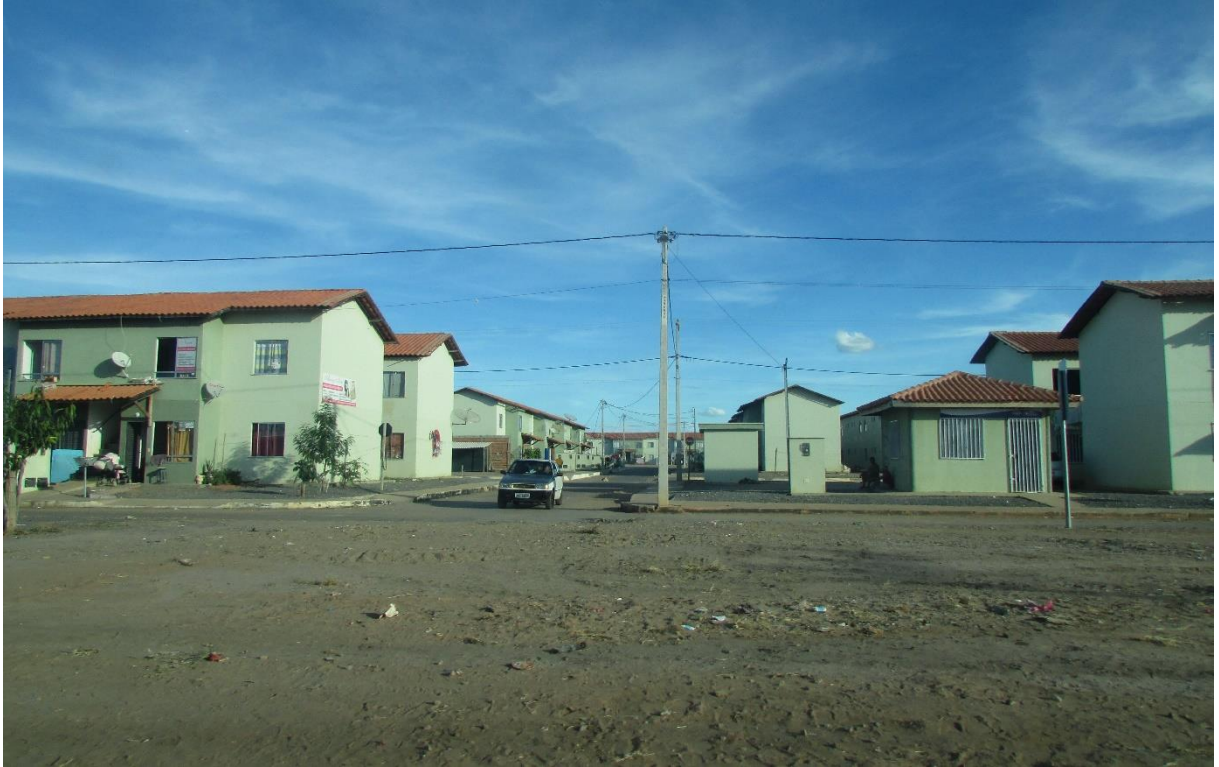
Figura 29 - Residencial Solar dos Buritis, próximo ao loteamento Jardim das Oliveiras, Luís Eduardo Magalhães – BA, 2017. Fonte: K. R. Almeida, 2017.
