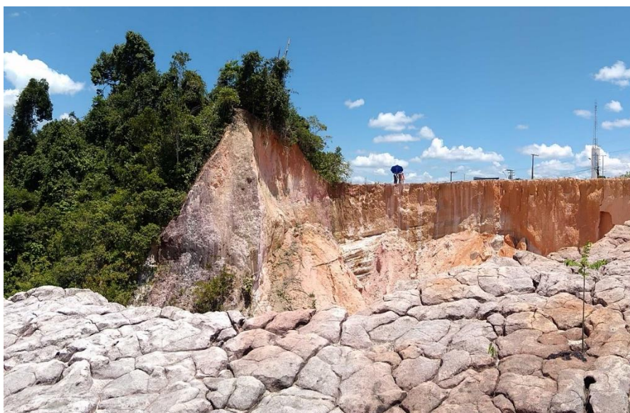
Figura 76: Voçoroca localizada, no bairro Distrito Industrial II, BH Colônia Antônio Aleixo. Foto: Armando Brito da Frota Filho, 2018.
