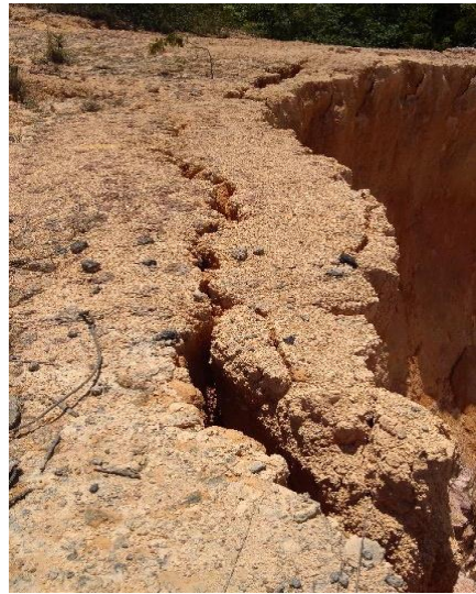
Figura 58: Fenda de tração na borda da voçoroca 01, bairro Distrito Industrial II. Fonte: Armando Brito da Frota Filho, 2018.
