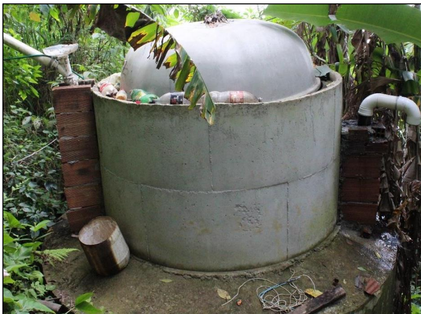
Figura 42 - Biodigestor de resíduos sólidos instalado na favela do Vale Encantado
