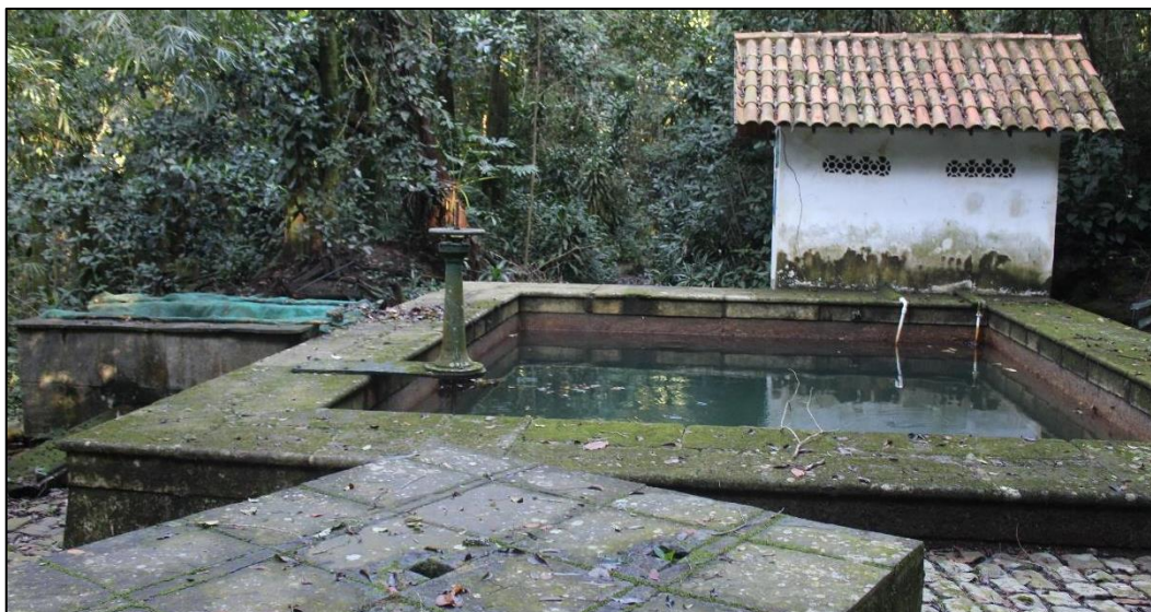
Figura 15 - Caixa 1 (decantador) do sistema de captações de água UT Gávea Pequena
