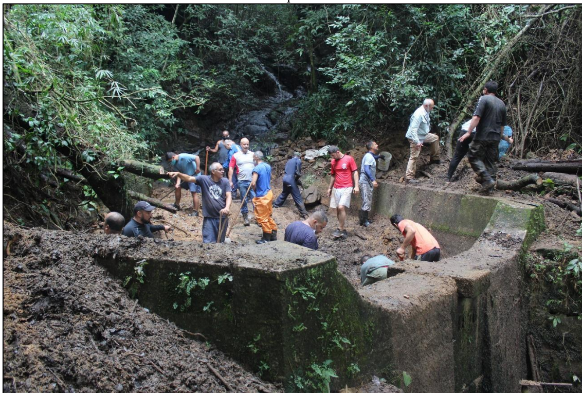
Figura 17: Mutirão de desassoreamento de uma das caixas de captação de água do sistema Gávea Pequena
