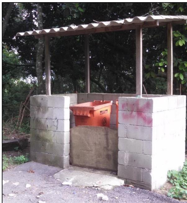
Figura 37 - Ponto de coleta coletivo construído pela Associação de Moradores do Vale Encantado
