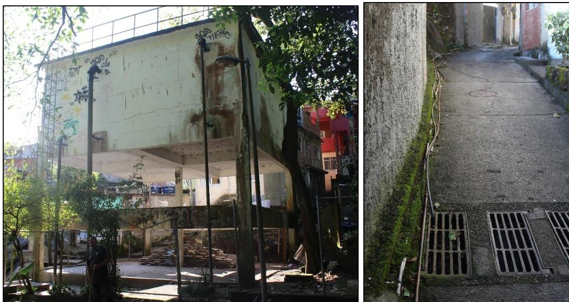
Figura 8 - Caixa d'água e pavimentação com rede de drenagem pluvial da favela Mata Machado construídas pelo programa Favela-Bairro
