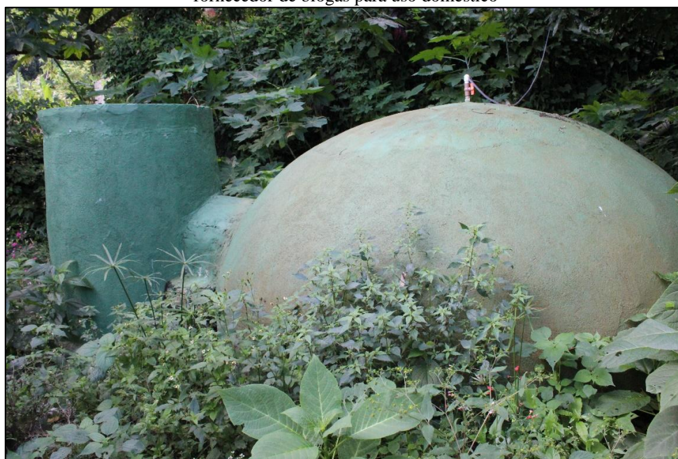
Figura 43 - Biodigestor utilizado no tratamento do esgoto produzido na favela do Vale Encantado e fornecedor de biogás para uso doméstico
