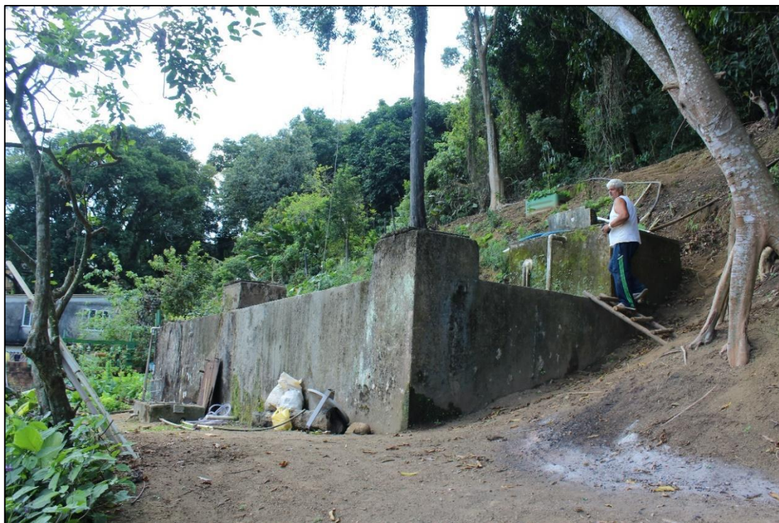
Figura 28 - Caixa d'água construída pela Associação de Moradores da Comunidade Agrícola
