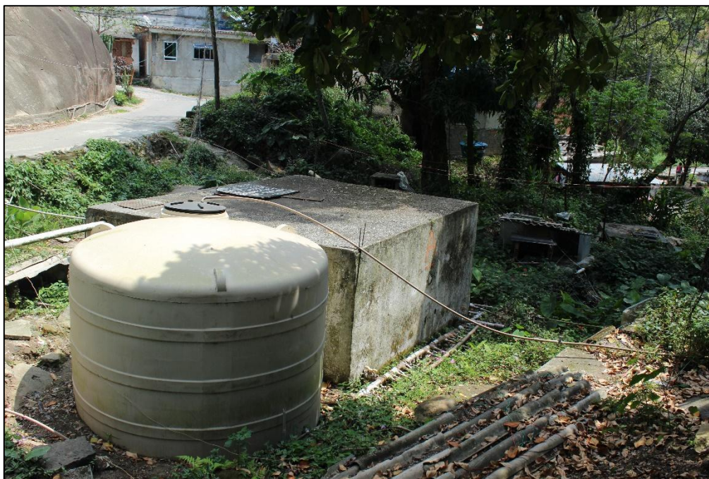
Figura 31 - Cisterna da favela Fazenda feito de concreto e reservatório mais recente feito de fibra
