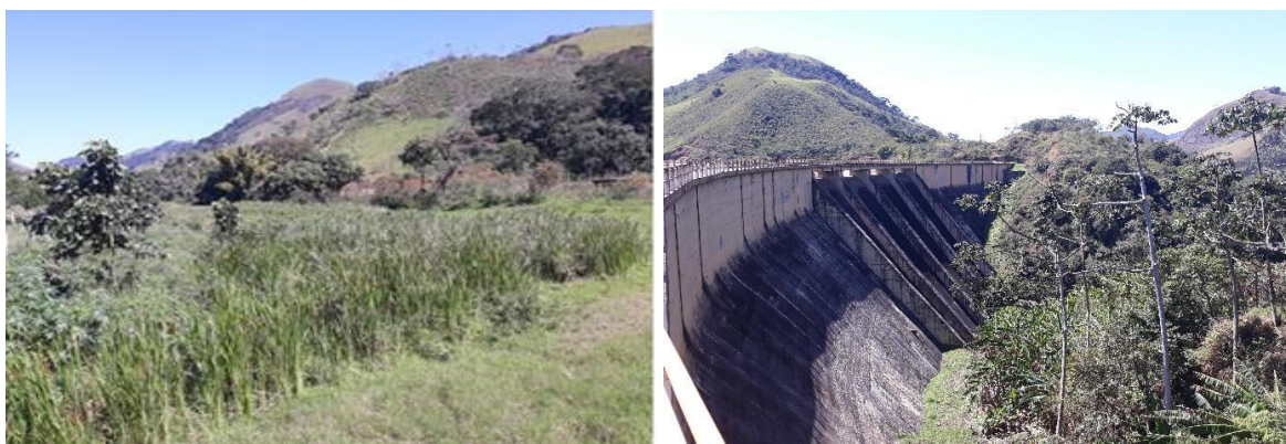
Figura 5 – (a) Rio Macabu entulhado de sedimentos, com a presença de vegetação típica de brejo, na localidade de Sodrelândia; (b) Barragem de Sodrelândia, com entulhamento de sedimentos e vegetação de médio e grande porte. Fonte: Acervo Grupo GEOMORPHOS/UFRJ (2018).
