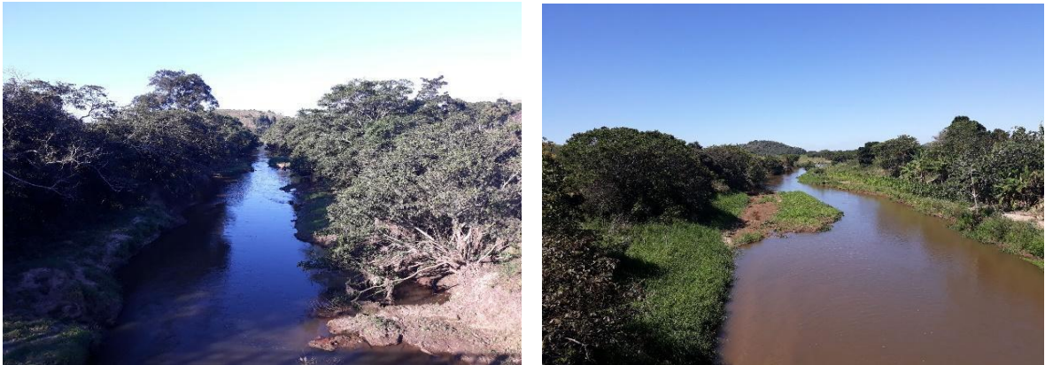
Figura 48 - Estilo Fluvial em ruim condição geomorfológica. Ambas as figuras mostram trechos canalizados no baixo e médio curso do rio Macabu e a presença de feições geomorfológicas como barras laterais. Fonte – Acerto Grupo Geomorphos/UFRJ (2018).
