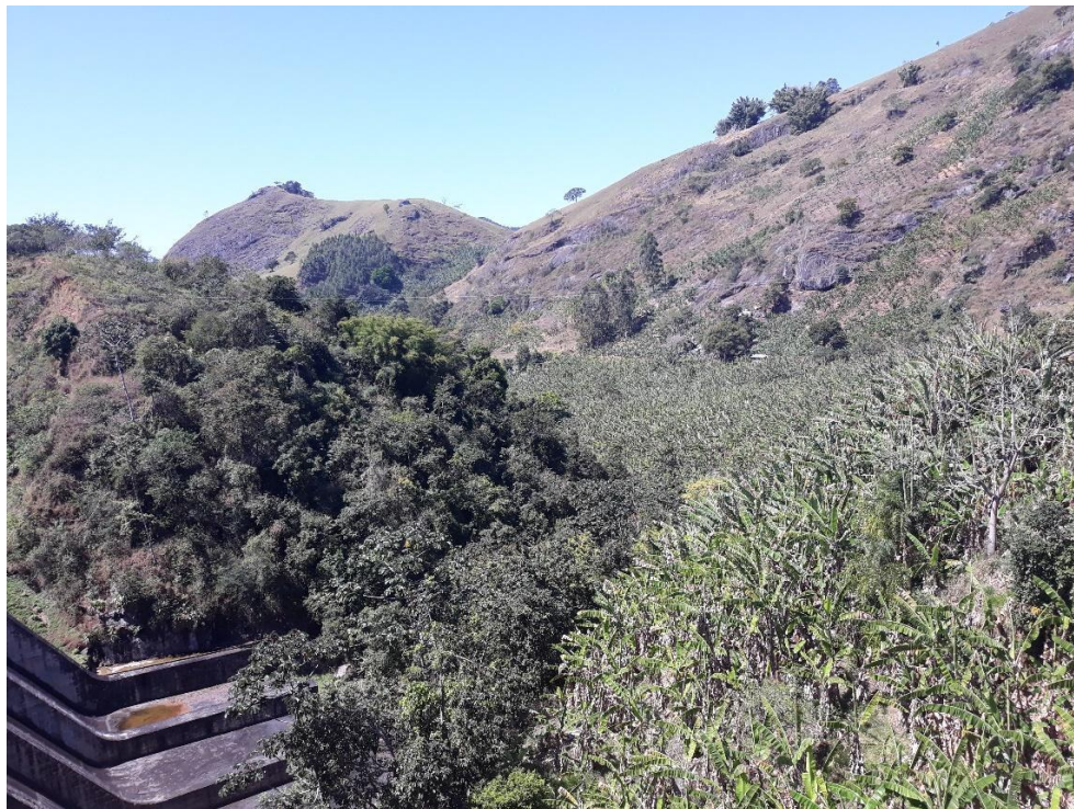
Figura 63 – Rio Macabu após as obras de transposição e barragem. Fonte: Acervo Grupo Geomorphos/UFRJ (2018).
