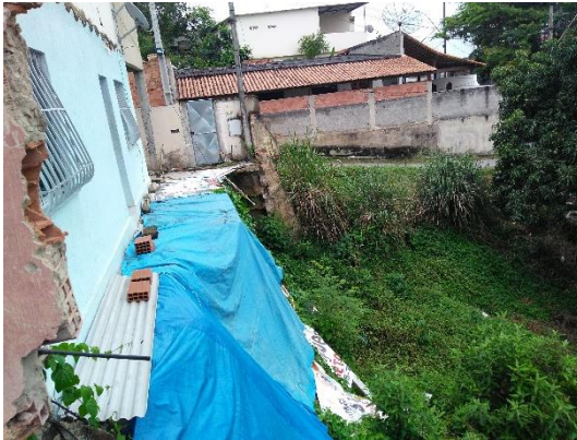
Figura 1.4: Registro fotográfico feito na Rua Fonseca Ramos, no Bairro Estrela do Norte em São Gonçalo, mesmo local do relatado na reportagem acima. As duas primeiras fotos mostram uma das casas que desmoronaram e as outras abaixo mostram a encanação exposta, a uma das casas que desmoronaram e as outras abaixo mostram a encanação exposta, a umidade do solo e a estrutura da casa com rachadura. Além da encosta com corte de solo que serviu como patamar para construção da casa que desmoronou. Fonte: Arquivo pessoal.
