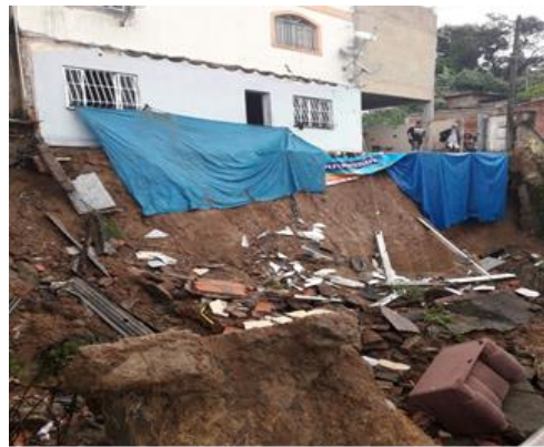
Figura 1.4: Registro fotográfico feito na Rua Fonseca Ramos, no Bairro Estrela do Norte em São Gonçalo, mesmo local do relatado na reportagem acima. As duas primeiras fotos mostram uma das casas que desmoronaram e as outras abaixo mostram a encanação exposta, a uma das casas que desmoronaram e as outras abaixo mostram a encanação exposta, a umidade do solo e a estrutura da casa com rachadura. Além da encosta com corte de solo que serviu como patamar para construção da casa que desmoronou. Fonte: Arquivo pessoal.
