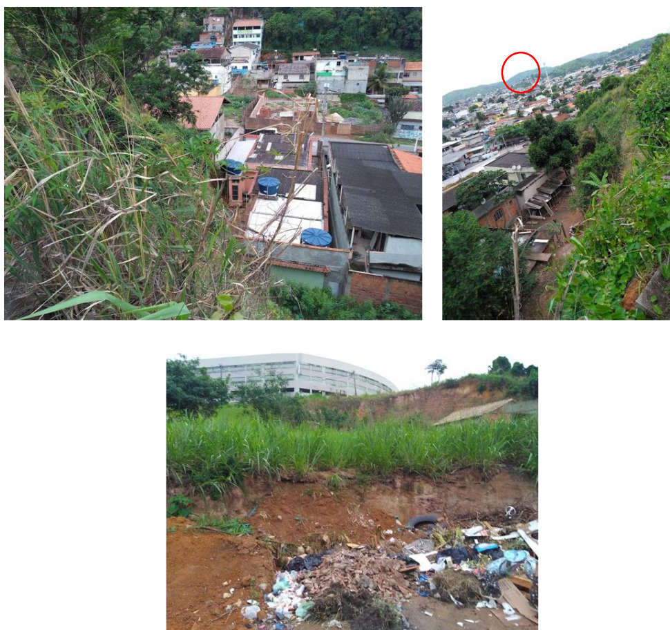
Figura 5.31: Registros de pontos da Av. Macedo Soares com visão de ponto irregular de descarte de lixo, ocupações próximas a encostas e em destaque a sirene de alerta. Arquivo Pessoal, novembro, 2019.
