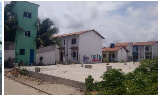
26i – Obras abandonadas da creche comunitária. Fonte: Foto do autor, fevereiro de 2017.
