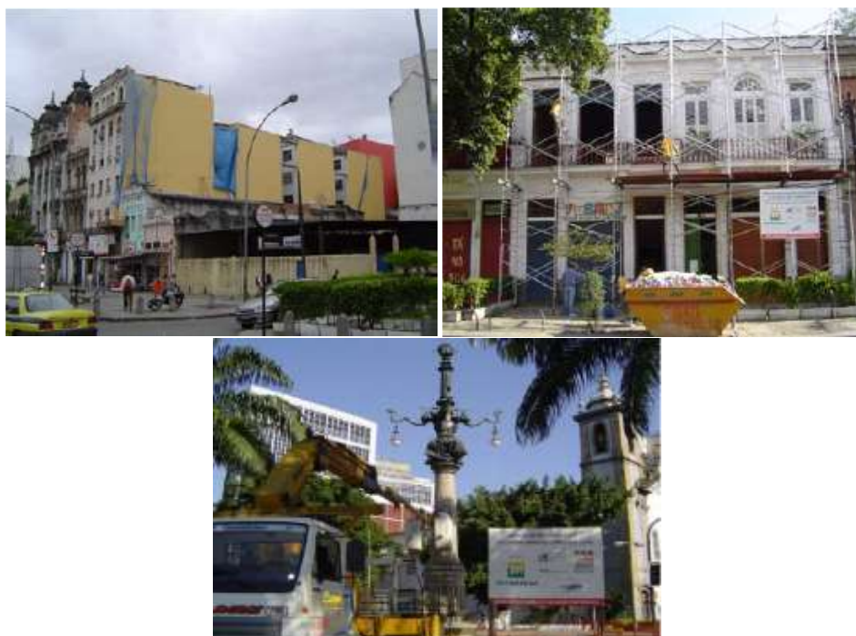
Figura 16: Obras de revitalização realizadas na Lapa 58
