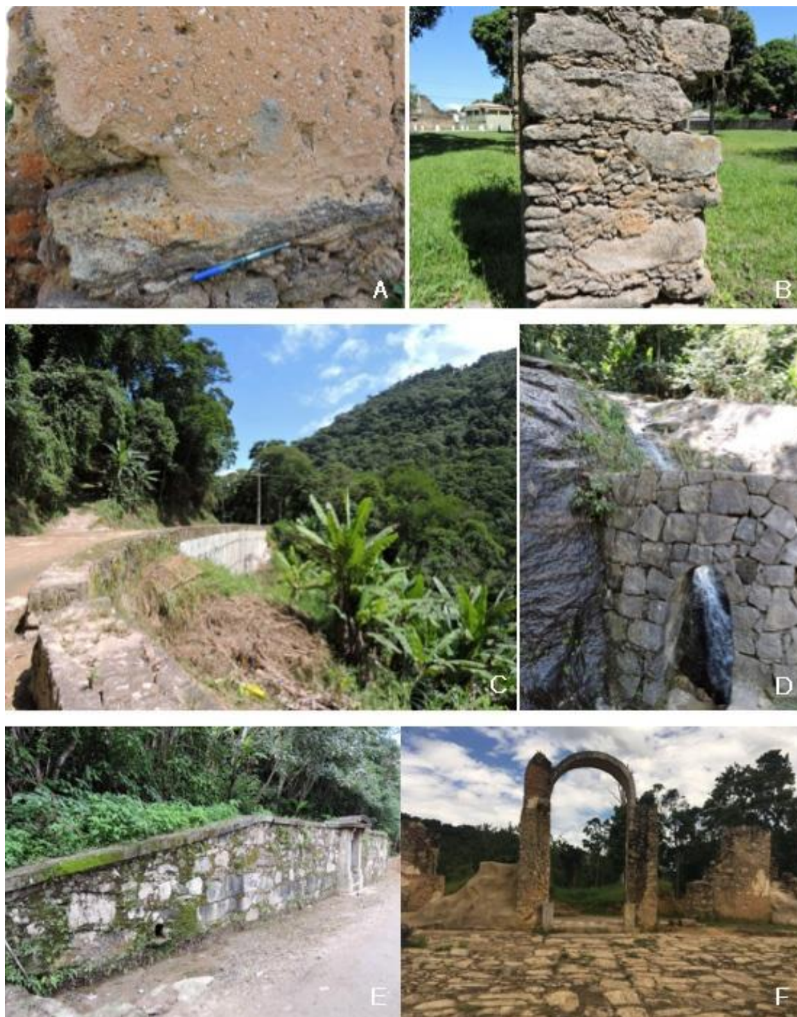
Figura 16: Imagens que ilustram os materiais utilizados nas construções ao longo da Serra do Piloto, em sua maioria granitos. A – Detalhe de construção do Parque das Ruínas; B – Ruína presente no Parque das Ruínas – Saco de Baixo; C – Material utilizado para proteção na Cachoeira dos Escravos; D – Mureta de proteção na Cachoeira dos Escravos; E – Detalhe arquitetônico do Bebedouro da Barreira; F – Ruínas de São João Marcos. Fotografias: E.A.L.Pocidonio (fevereiro/2017).
