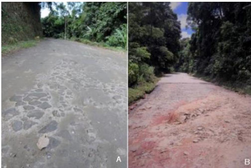
Figura 10: Trechos tombados da Estrada Imperial que visa à preservação da macamização na estrada. Fotografias: A – T.M.Silva (abril/2017); B – E.A.L. Pocidonio (fevereiro/2017).
