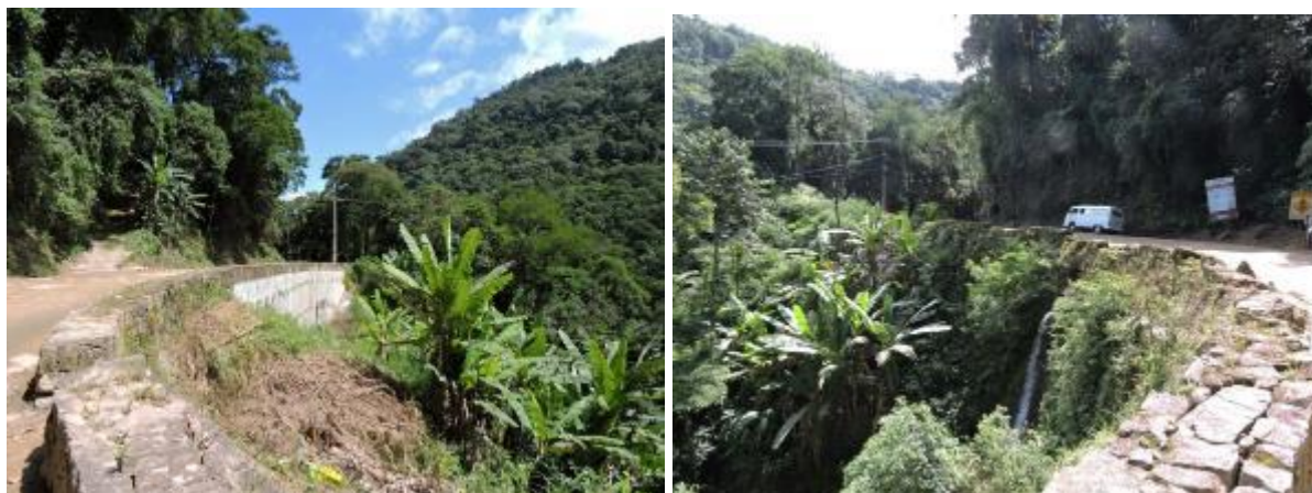
Figura 29: Obras de contenção realizadas ao redor da Cachoeira dos Escravos em 2014 decorrente de fortes chuvas no local. Fotografia: E.A.L.Pocidonio (abril/2017).
