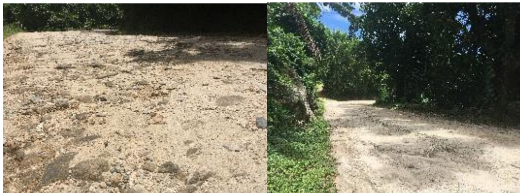
Figura 24: Trecho da Estrada Imperial ao lado do Mirante Imperial em estado de conservação preconizado. Fotografia: E.A.L.Pocidonio (janeiro/2017).
