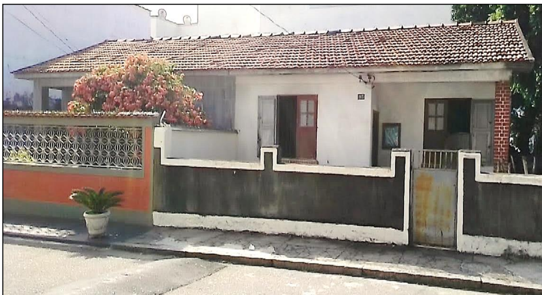
Figura 35 – Casa com janelas e portas de madeira (direita) contendo tijolinhos em sua coluna.
