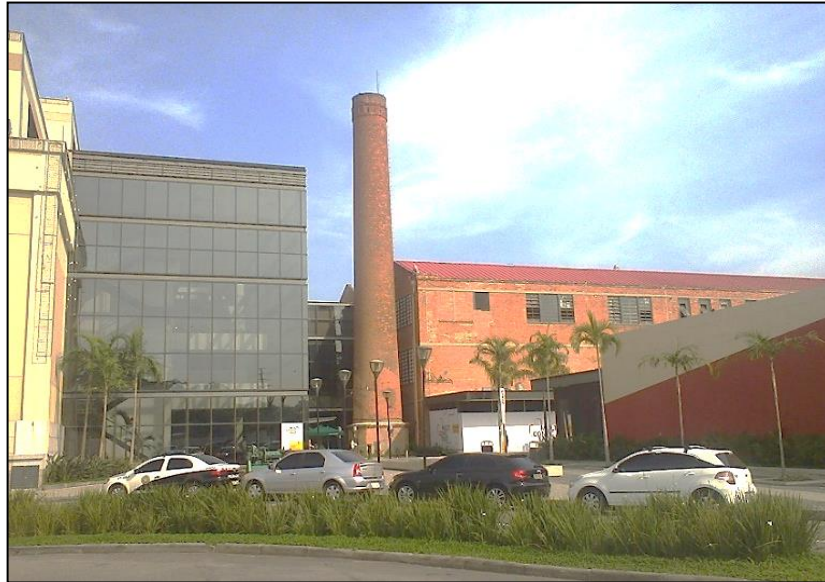
Figura 3 – A chaminé da fábrica e um dos prédios da mais recente expansão.
